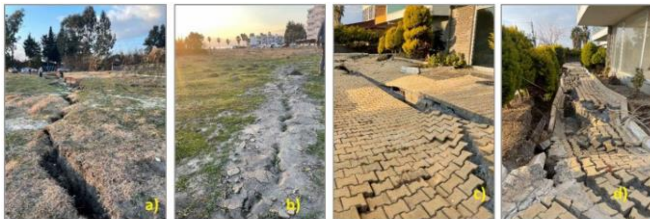
Εικόνα 10: Αστοχίες λόγω ρευστοποίησης που παρατηρήθηκαν στην περιοχή Dörtyol του Hatay (Demir et al., 2023).
