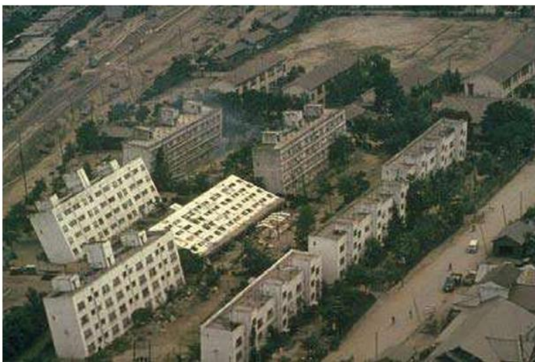
Εικόνα 1: Αστοχίες λόγω ρευστοποίησης στο σεισμό της Niigata το 1964 (Elfass et al., 2006)
