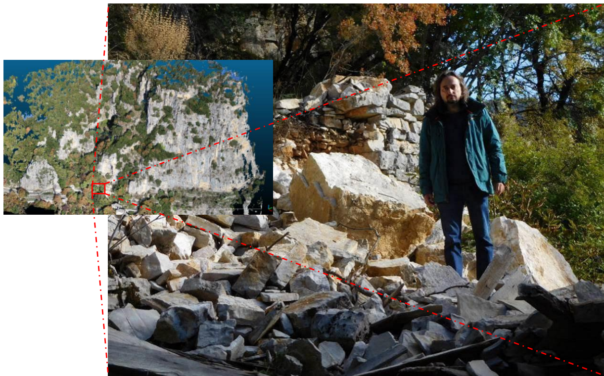
Εικόνα 32: Άποψη της αστοχίας Μαρτίου – Απριλίου 2020 στη θέση κατάρρευσης των παλαιών ανενεργών κελιών. Οι πεσμένοι βραχώδεις όγκοι ήταν μέγιστου μεγέθους περί του 1\text{m}^3 .
