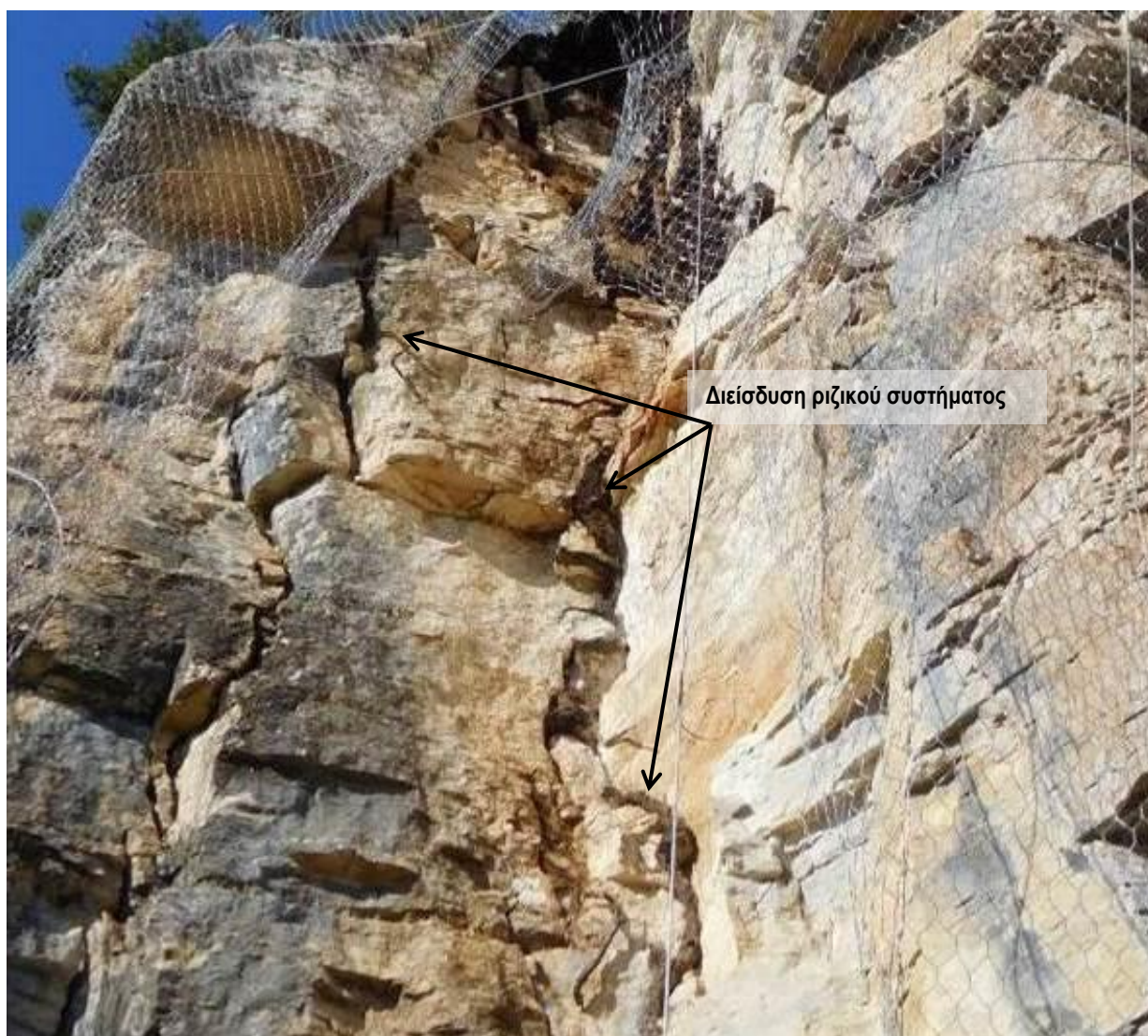
Εικόνα 19: Παρουσία ριζικού συστήματος θαμνοειδούς βλάστησης, εντός των διακλάσεων του ασβεστόλιθου, στη θέση της αστοχίας της 7 ης Οκτωβρίου 2021.
