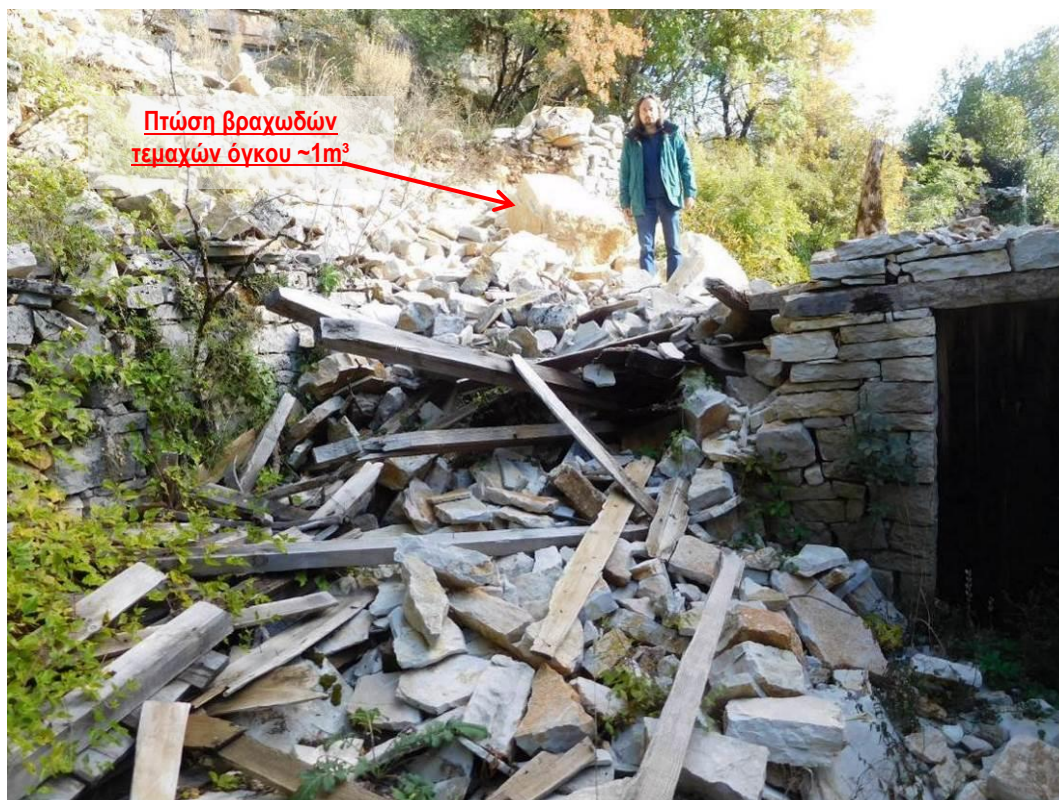
Εικόνα 10: Καταστροφή του κελιού της μονής λόγω της εκδήλωσης βραχώπτοσεων την περίοδο Μάρτιος – Απρίλιος 2020, σε απόσταση περί τα 60m νοτιοδυτικά του μελετώμενου πρανούς.
