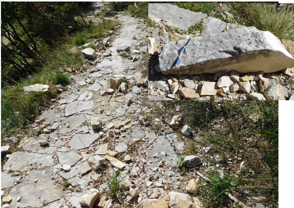
Εικόνα 16: Μικρά ασβεστολιθικά τεμάχια, πεσμένα επί του λιθόκτιστου μονοπατιού, στο πόδι του μελετώμενου πρηνούς.
