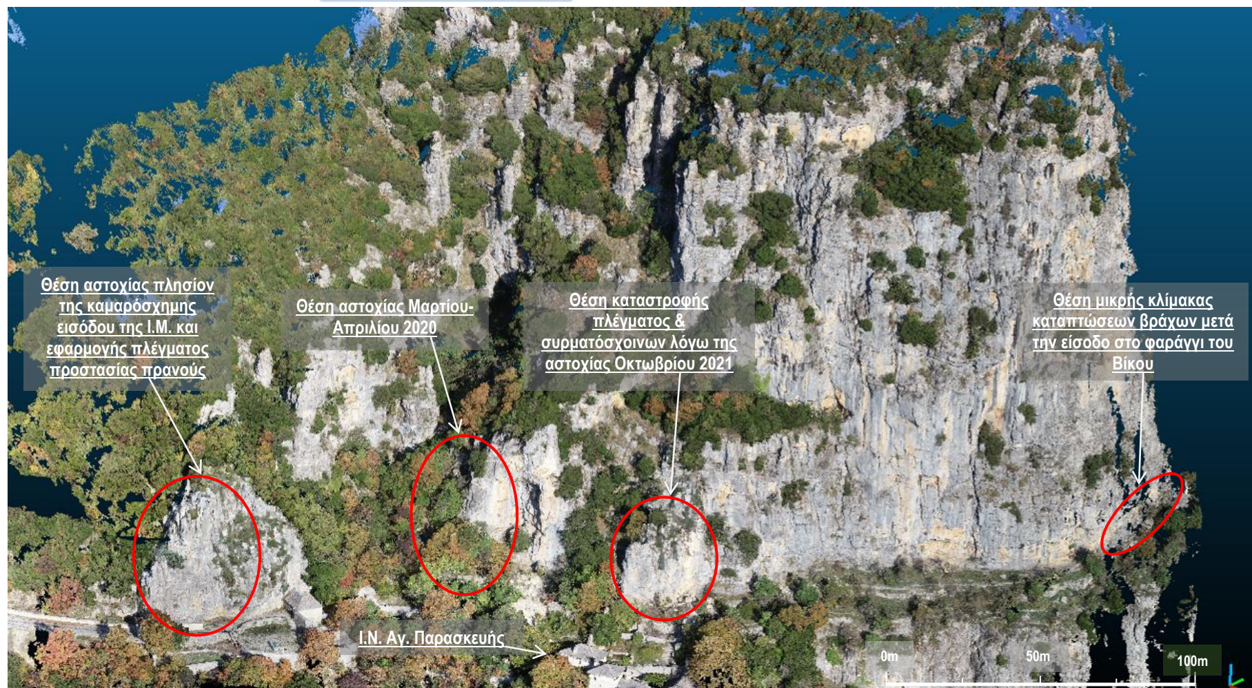
Εικόνα 18: Το πρανές ανάντη της Ι.Μ. Αγ. Παρασκευής, όπως προέκυψε από το νέφος σημείων (point cloud) που δημιουργήθηκε μετά τη λήψη φωτογραφιών από μη επανδρωμένο αερόχημα (UAV) στις 21 Οκτωβρίου 2021. Διακρίνονται οι θέσεις των καταγεγραμμένων αστοχιών.
