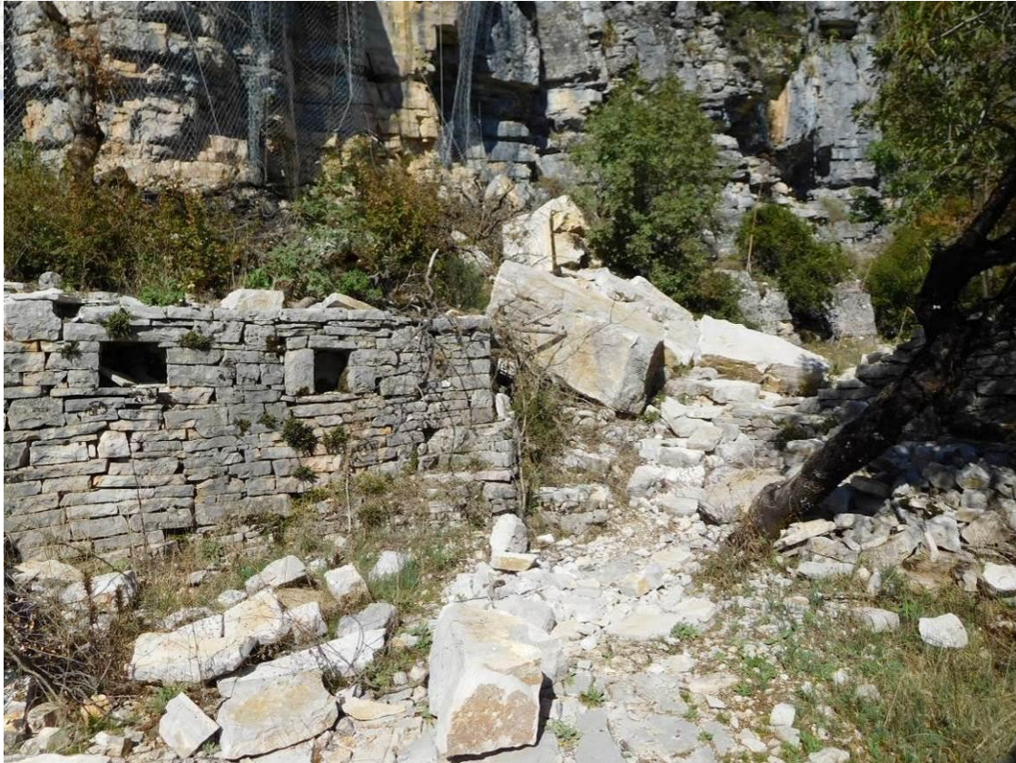
Εικόνα 15: Σημαντικού όγκου ασβεστολιθικά τεμάχια, στο πόδι του μελετώμενου πρानούς λόγω της αστοχίας στις 7 ης Οκτωβρίου 2021.
