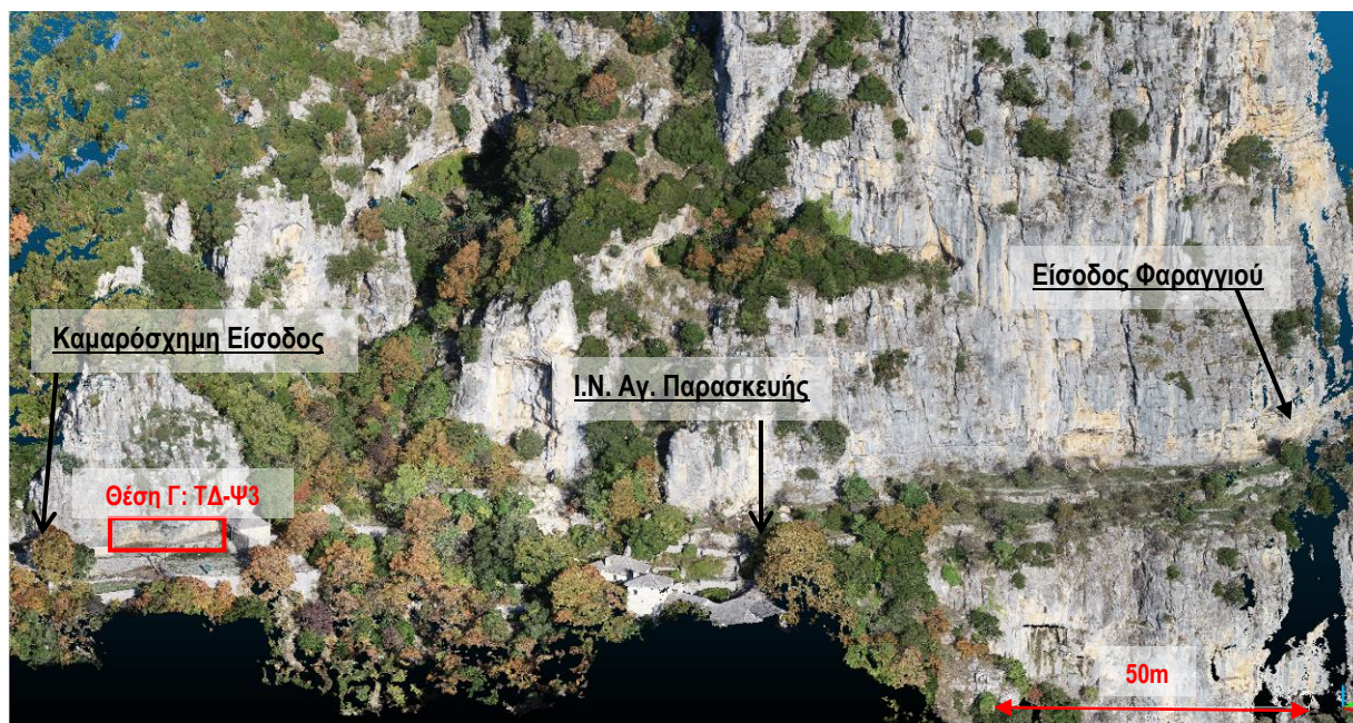
Εικόνα 27: Γενική άποψη ολικού πρανούς Ι.Μ. Αγ. Παρασκευής. Διακρίνεται η θέση Γ σύνταξης του ψηφιακού τεκτονικού διαγράμματος ΤΔ-Ψ3.
