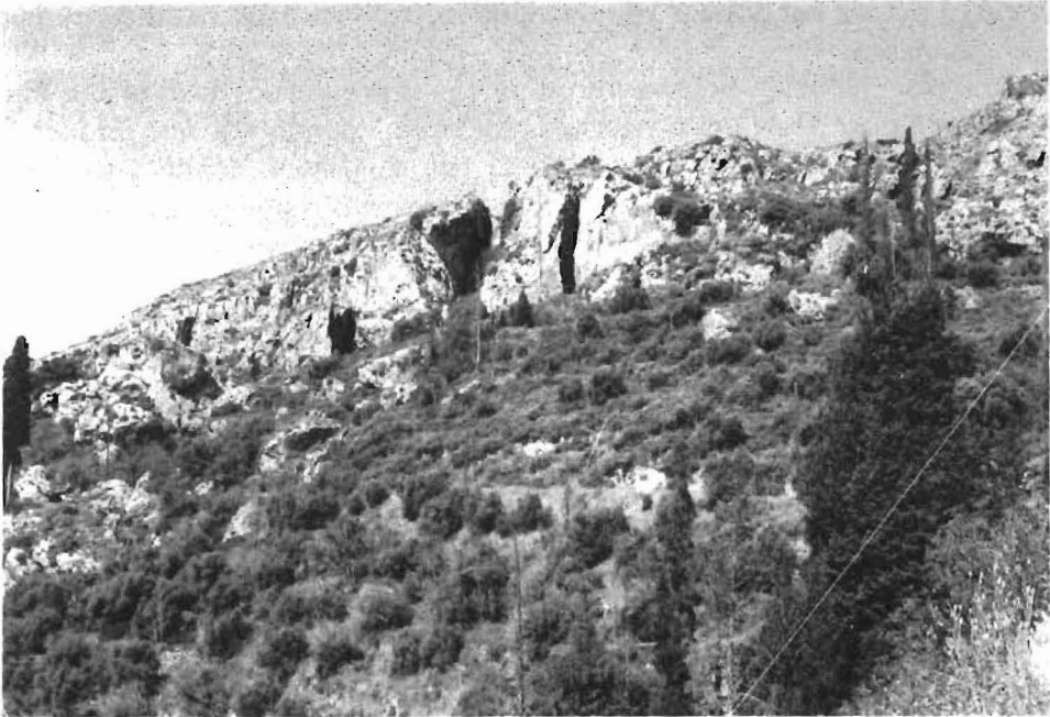
Φωτ. 2. Ολίσθηση συνεκτικού τεκτονικού λατιποπαγούς με ταυτόχρονη δημιουργία μεγάλων χασμάτων βόρεια του οικισμού του Αχιλλείου.
