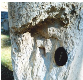
Σχήμα 3. Μαργαίος ασβεστόλιθος σε κίονα του ναού με έντονη αποκόλληση τεμαχίου
