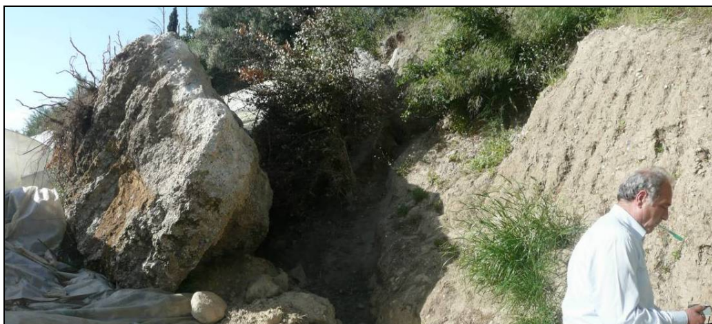
Εικ. 7. Σύγχρονη κατάπτωση μεγάλου ογκόλιθου στο δυτικό όριο του χώρου ανασκαφών.
