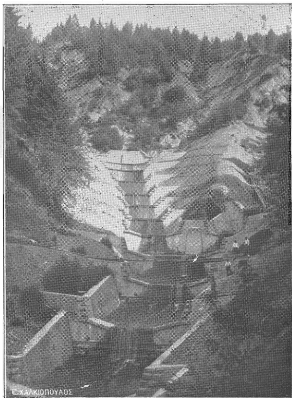
Εικ. 6. Έγκάρσια φράγματα εκ σκυροκονιάματος ως και μικτά εκ ξύλων και λίθων τοιαῦτα, ιδρυθέντα ἐν τῇ ὄρεινῃ κοίτῃ τοῦ χειμάρρου Schiefingbach παρὰ τὴν Ossiachersee τῆς Αὐστρίας μετὰ παραλλήλων τοίχων πρὸς στερέωσιν αὐτῆς.
