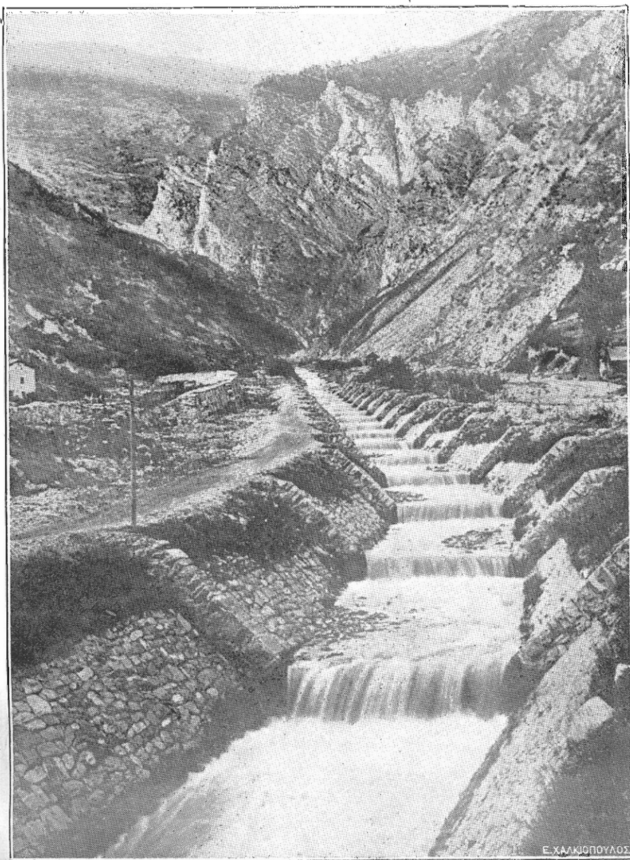
Εικ. 13. Τεχνικά ἔργα ἐκτελεσθέντα ἐν τῷ κῶμφ ἀποθέσεως τοῦ χειμάρρου St Julien τῆς Γαλλίας μετὰ τὴν ἐκτέλεσιν ἐν τῇ συλλεκτικῇ λεκάνῃ αὐτοῦ τῶν ἐνδεικνυομένων φωτοκομικῶν καὶ τεχνικῶν ἔργων (δηλ. μετὰ τὴν ἀπόσβεσιν αὐτοῦ, μεταβολὴν εἰς ῥύακα) [Εἰκ. 100 ἐν τῇ (35)]
