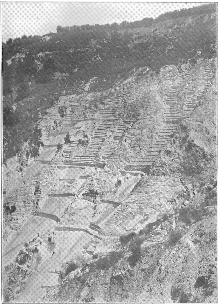
Εικ. 8. Προπαρασκευή της λεκάνης απορροής του χειμάρρου Ταορμίτι της Ίταλίας πρὸς ἀναδάσωσιν διὰ κατασκευῆς τοίχων ὑποστηρίξεως τοῦ ἐδάφους, βαθμίδων, ἐγκαρσί- ων τάφρων κλπ. Ἀριστερὰ καὶ ἄνω ἀναθάμνωσις διὰ Sarothamnus scorarius Koch. μετὰ τὴν ἐκτέλεσιν ἀναλόγων τεχνικῶν ἔργων. Ἀχρῆστευσις τῶν τεχνικῶν ἔργων μετὰ τὴν ἐπιτυχίαν τῆς ἀναδάσώσεως.
