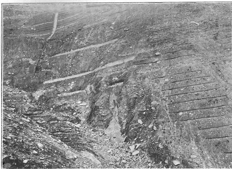
Εικ. 7. Προπαρασκευή τῆς λεκάνης ἀπορροῆς τοῦ χειμάρρου Orsigna Pistoja τῆς Ἰταλίας πρὸς ἀναδάσωσιν. Ἔργα στερεώσεως τοῦ ἐδάφους (ἐγκάρσια φράγματα, τοῖχοι ὑποστηρίξεως τοῦ ἐδάφους, τάφροι ἀποστραγγίσεως κλπ.) (Φωτ. Χριστοῦ Μουλοπούλου, 9-VII-1930)
