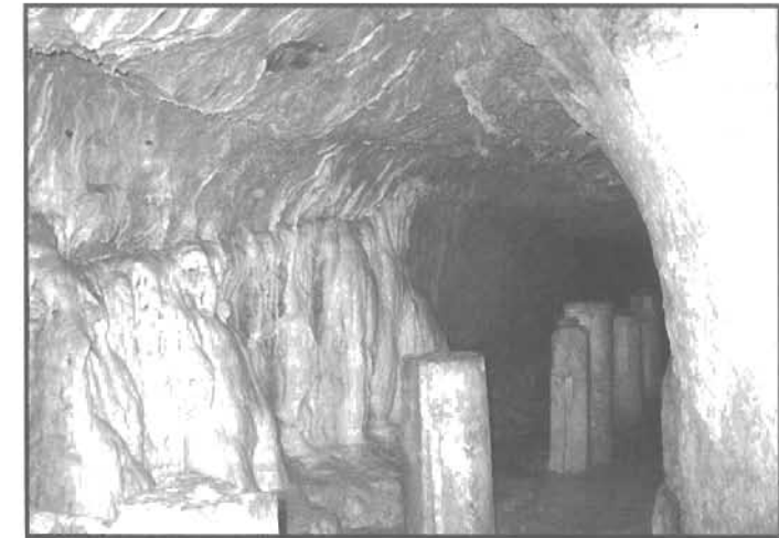
Σχήμα 7. Δράση καρστικού νερού στη σήραγγα του Ευπαλινείου. Διακρίνονται επιχρίσματα και αποθέσεις \text{CaCO}_3 μέσα στο χώρο της σήραγγας.
