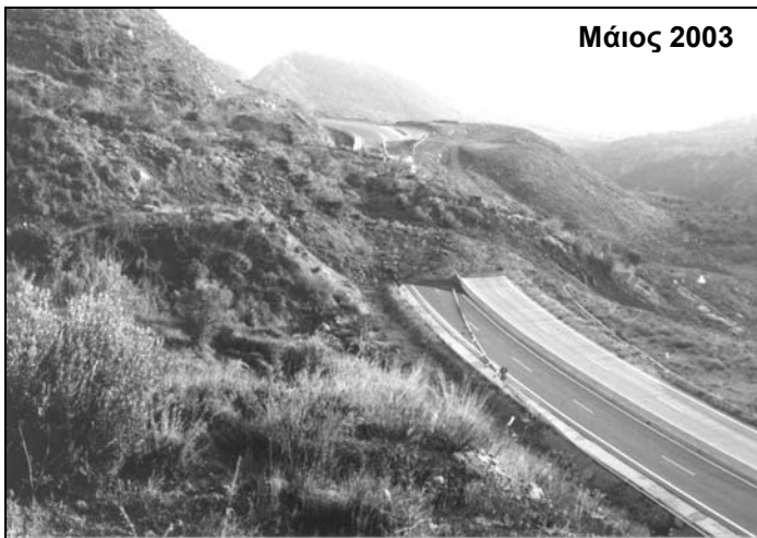
Σχήμα 1. Γενική άποψη από βορά προς νότο της κατολίσθησης στην Τσακώνα μετά την ολοκλήρωση του φαινομένου το Μάιο του 2003.
