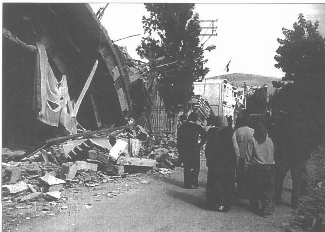
Fig. 5: Collapsed building. Ψηφιακή Βιβλιοθήκη "Θεόφραστος" στην Τμήμα Γεωλογίας, Α.Π.Θ.
