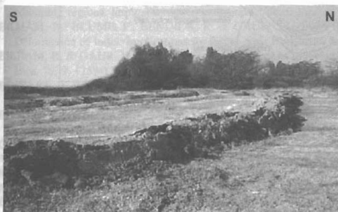
Εικ. 4α. Η μεγαλύτερη σεισμική διάρρηξη με διεύθυνση Α-Δ (μήκος 1,5 Km και μέτωπο γύρω στα 60 cm) στην ανατολική προέκταση της ρηξιγενούς ζώνης του Kachchh Mainland Fault.
