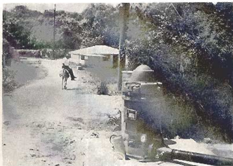
Είκ. 2. Ή νέα γεώτρησης Α του δημοτικού ύδραγωγείου Ζακύνθου εις τήν περιοχήν Κεφαλοβρύσου. Εις τό βάθος τό οίκημα του κοινοτικού πλυντηρίου και άριστερά ή δεξαμενή τής αποξηρανθείσης πηγής.
