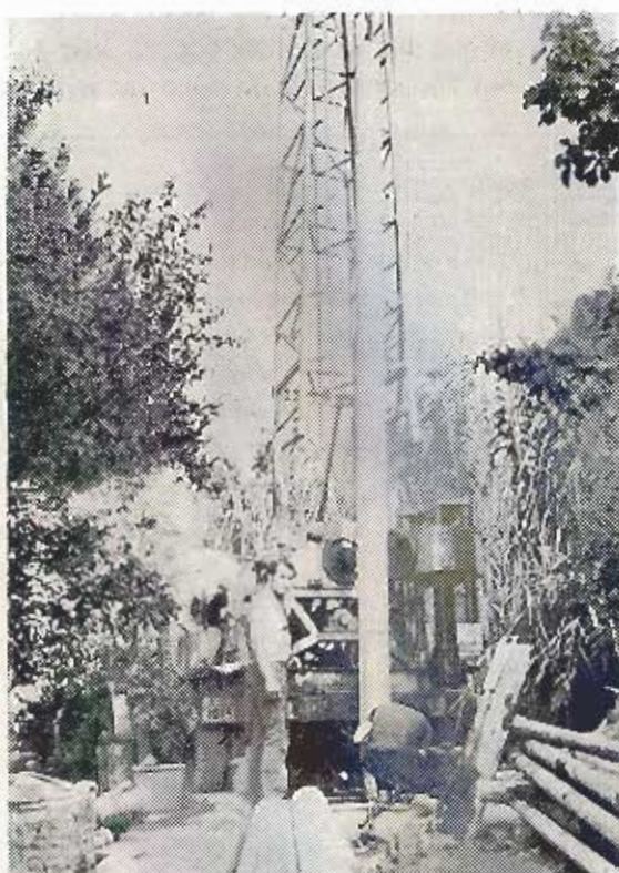
Εἰκ. 6. Τελικὴ σωλήνωση τῆς γεωτρήσεως.
