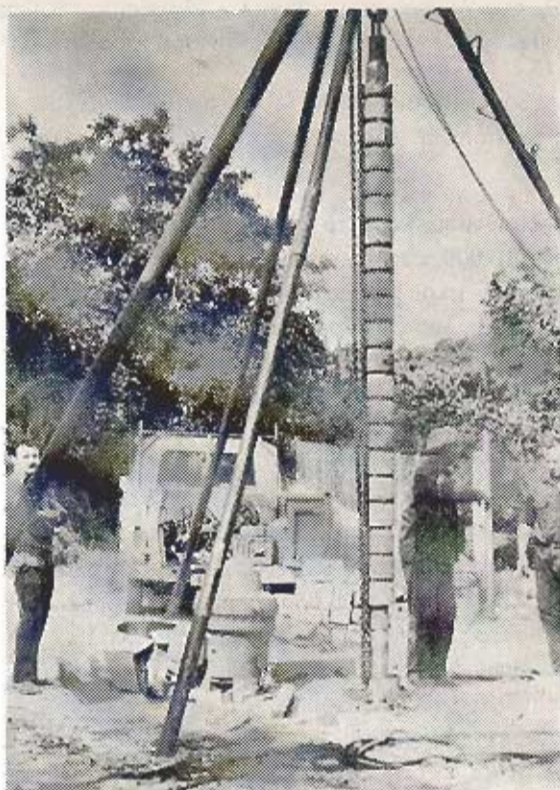
Εικ. 7. Έγκατάσταση άντλιας κατακορύφου άξονος.
