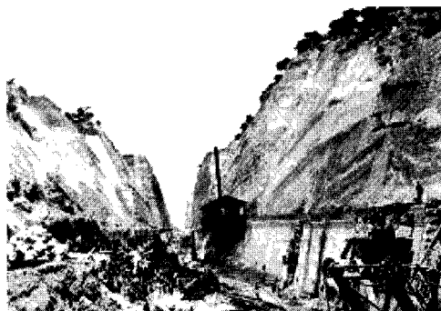
Σχήμα 3. Κατασκευή προστατευτικού λιθόδημνου κρηπίδοτοιχου κατά την εκσκαφή της διώρυγας
