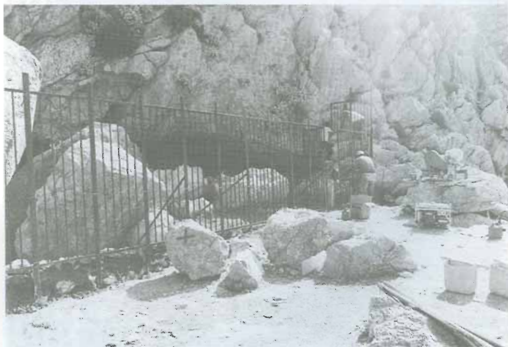
Εικ.2 Η είσοδος του σπηλαίου κατά το 1992-1993 ύστερα από την τοποθέτηση της βαρειάς μεταλλικής θύρας που το συνολικό της βάρος πλησιάζει τα 800 κιλά. Κατασκευάστηκε σε τεμάχια στην Αθίνα από μασσίφ μέταλλο και συναρμολογήθηκε επί τόπου.
