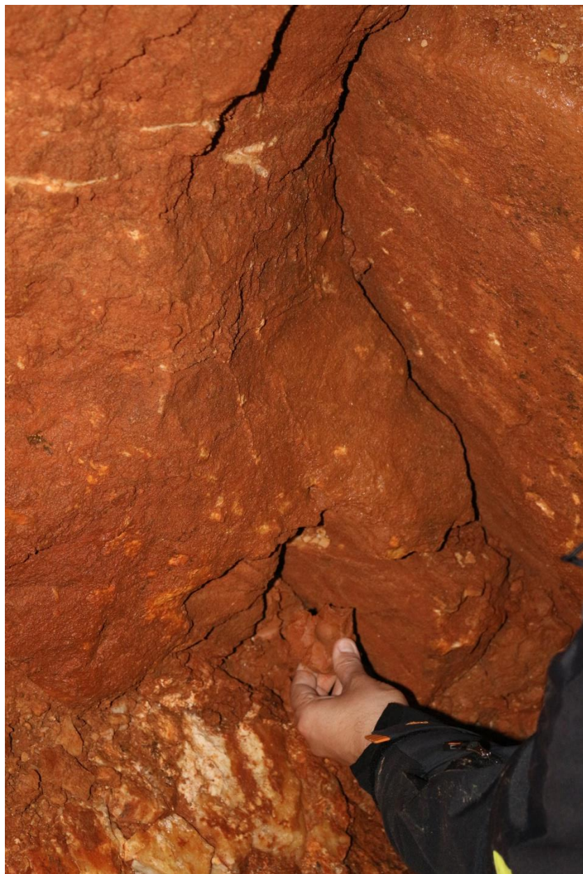
Εικόνα 28. Αργιλικό υλικό που συναντάται κατά μήκος ζώνης ρήγματος στο εσωτερικό της Στοάς2.
