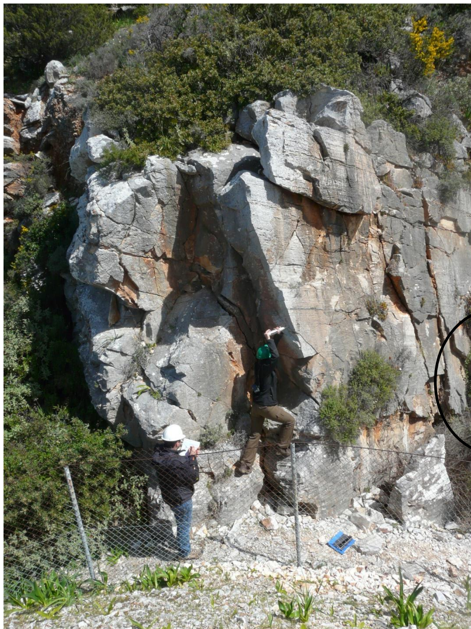
Εικόνα 30. Αποσπώμενο τέμαχος στη θέση στόμιο2α λόγω επίπεδης ολίσθησης.
