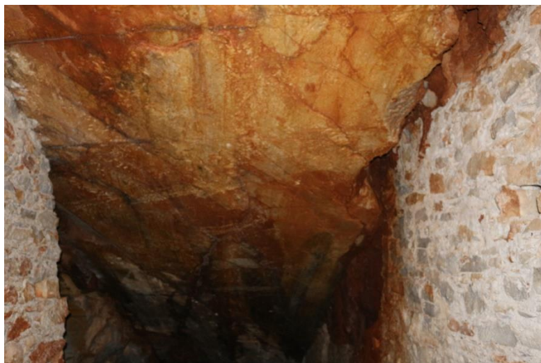
Εικόνα 35. Συμπαγής πάγκος μαρμάρου στην οροφή που δηλώνει μια γενική ευστάθεια των στοών.
