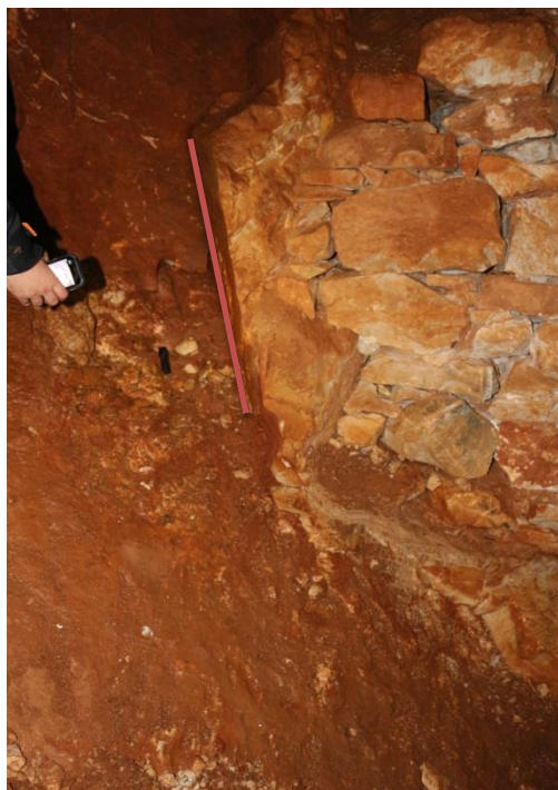
Εικόνα 47. Αργιλικό υλικό το οποίο έχει αποπλυνθεί από τη ζώνη ρήγματος στην οροφή της στοάς 2.
