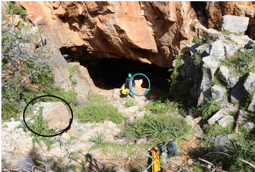
Εικόνα 34. Στόμιο 2β όπου διαπιστώνεται η παρουσία ογκόλιθων που έχουν αποκολληθεί από το πρανές.
