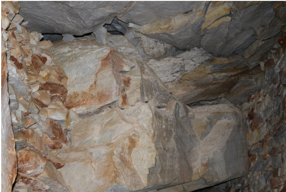
Εικόνα 41. Εγκάρσια στοά προς την στοά 2, στην οροφή της οποίας απαντώνται τεμάχια που πρέπει να απομακρυνθούν μηχανικά.
