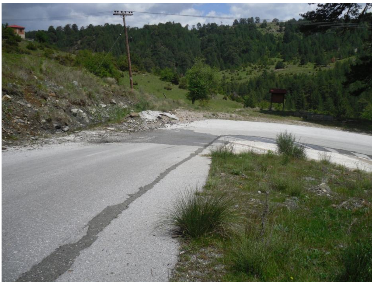
Εικόνα 5.5 Θέση 4, Απορροή υδάτων στο επίχωμα λόγω δημιουργίας μισγάγγειας
