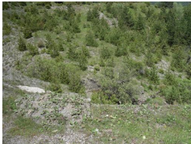
Εικόνα 5.12 Η συνέχεια της κατολίσθησης κατάντη του επιχώματος, θέση 8
