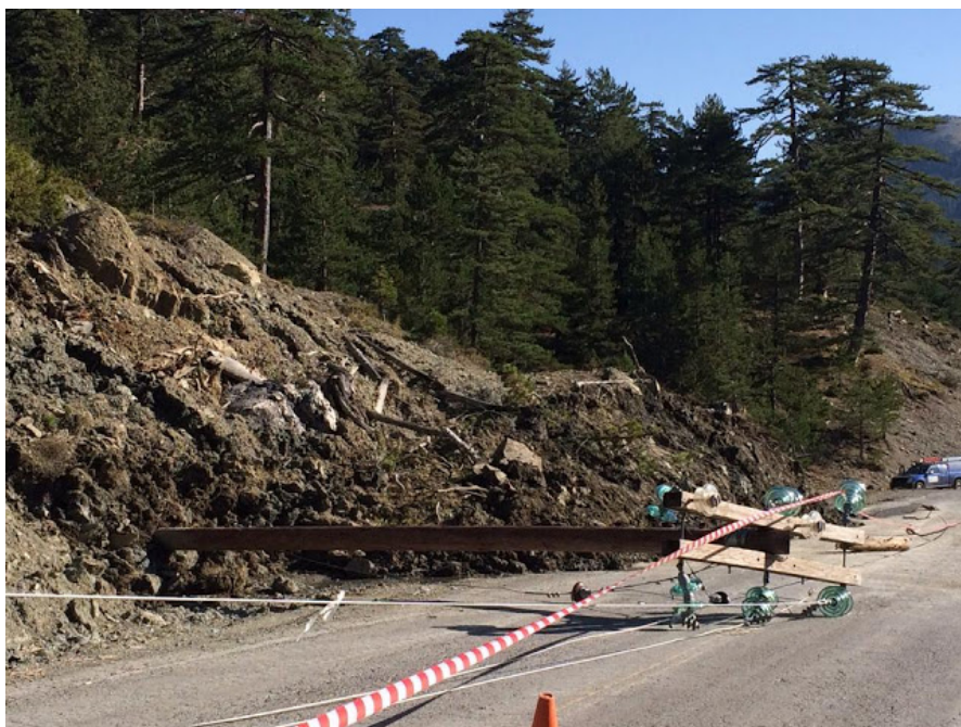
Εικόνα 3.1 Κατολίσθηση πρανούς στη Σαμαρίνα Γρεβενών
