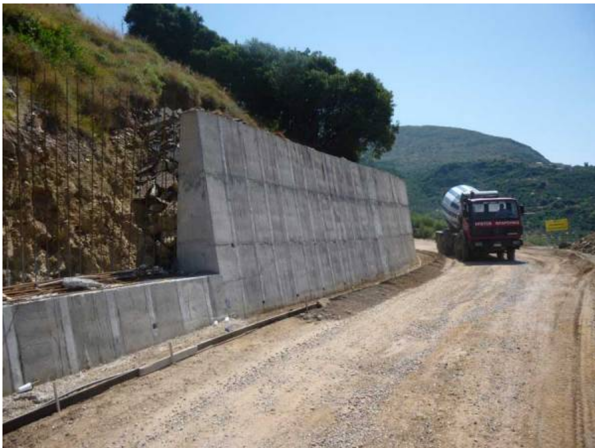
Σχήμα 1.3 Τοίχος αντιστήριξης (Σινάπης, 2014)
