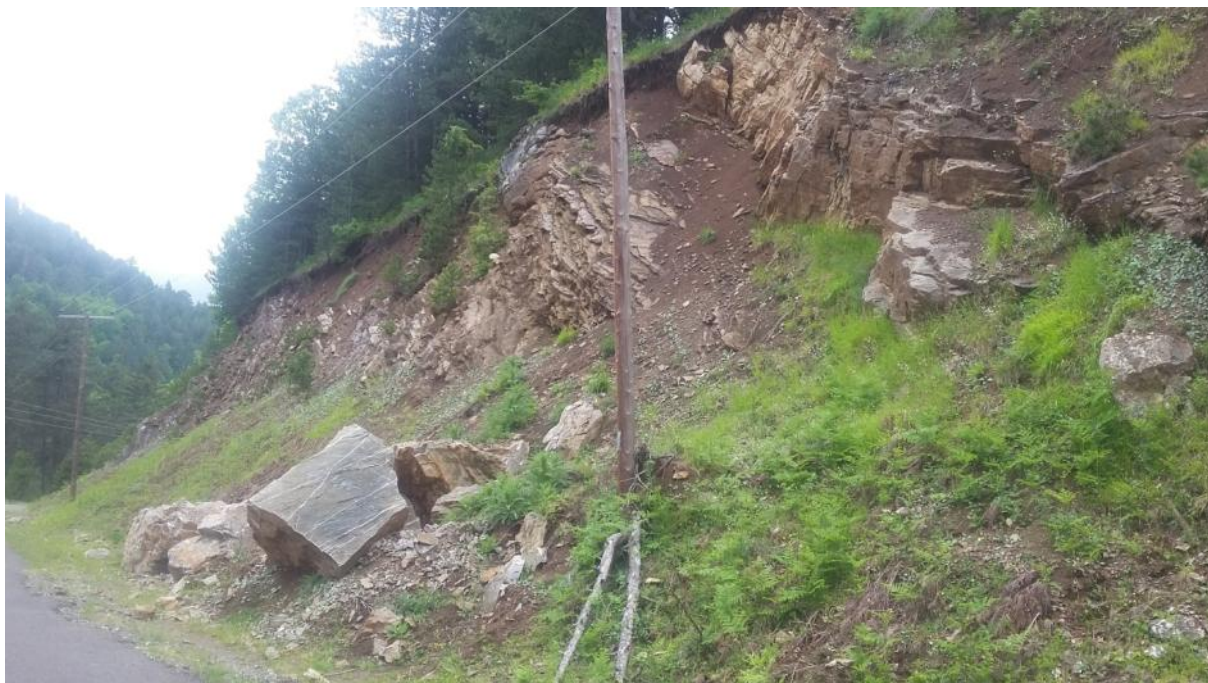
Εικόνα 5.27 Σφηνοειδής ολίσθηση, θέση 21
