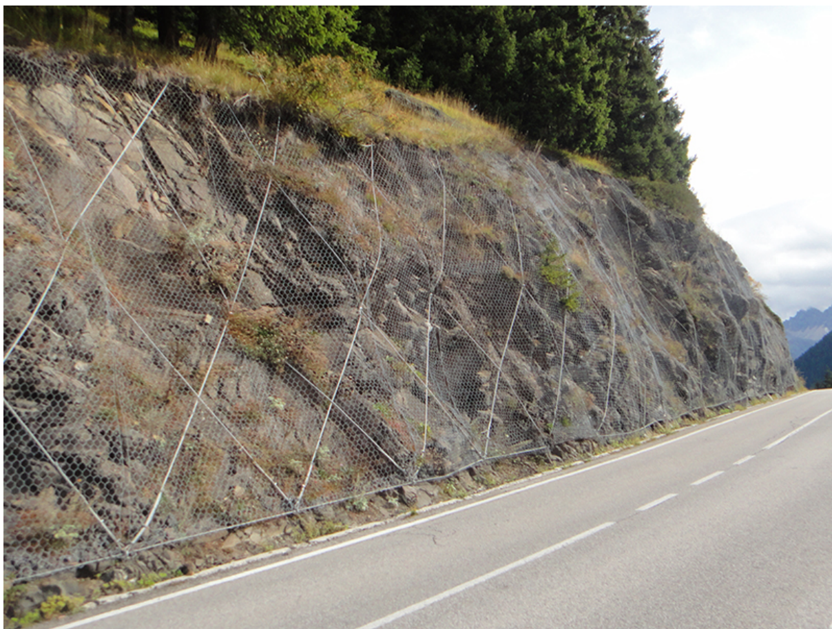
Εικόνα 1.9 Φράκτης συγκράτησης σε βραχώδες πρανές.
