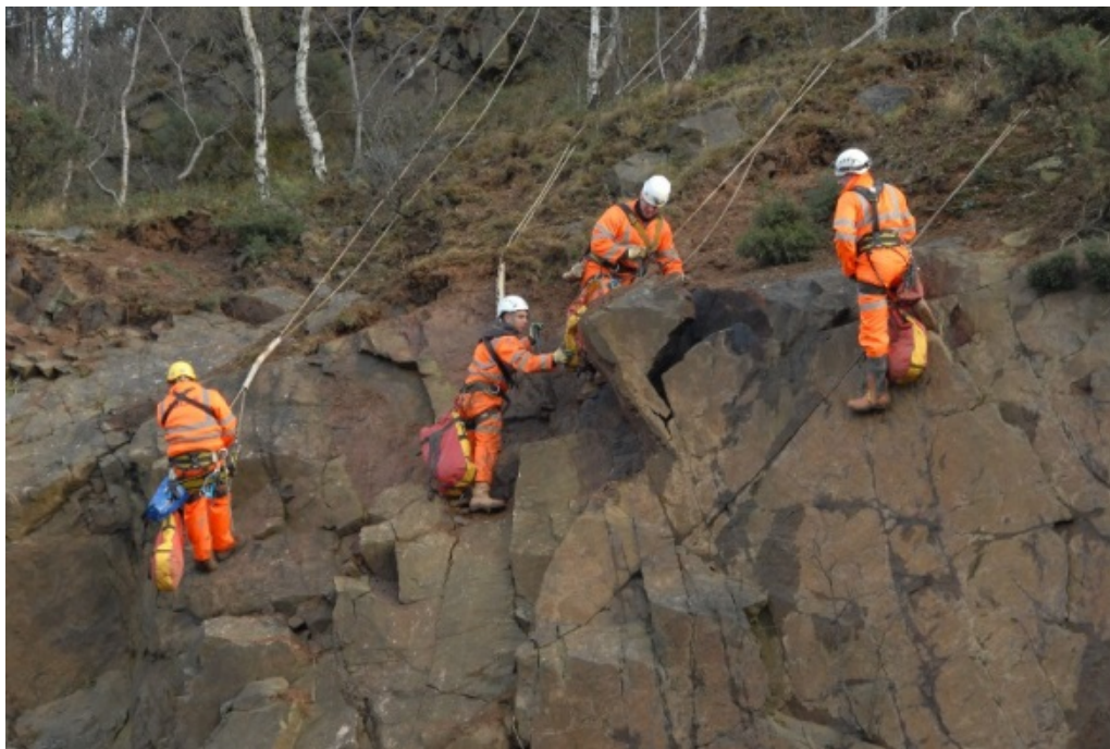
Εικόνα 1.7 Ξεσκάρωμα βράχων
