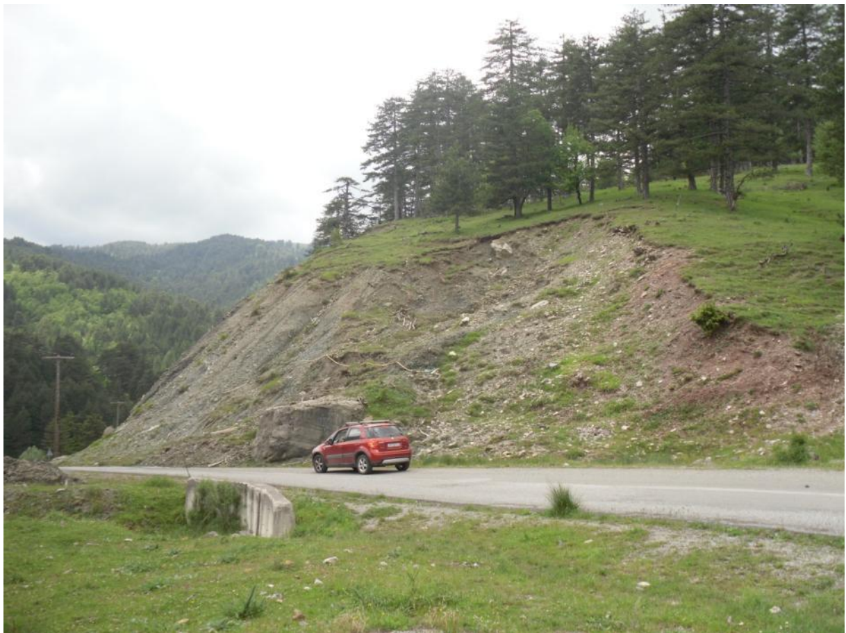
Εικόνα 5.18 Κατολίσθηση & παρουσία εφελκυστικών ρωγμών ανάντη του πρανούς, θέση 13
