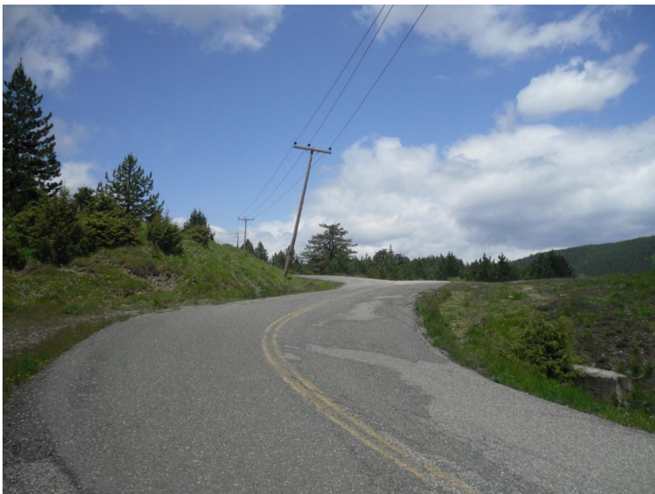
Εικόνα 5.10 Ο κεκλιμένος στύλος φωτισμού της Δ.Ε.Η., θέση 7
