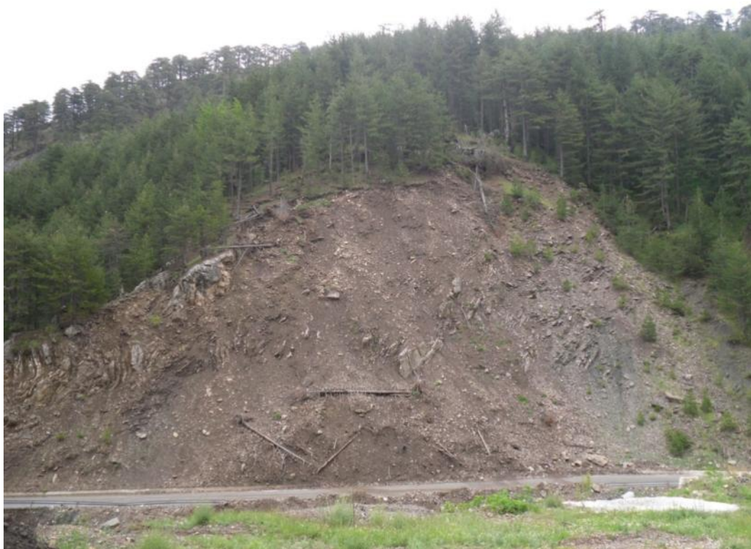
Εικόνα 5.23 Περιστροφική ολίσθηση, θέση 18
