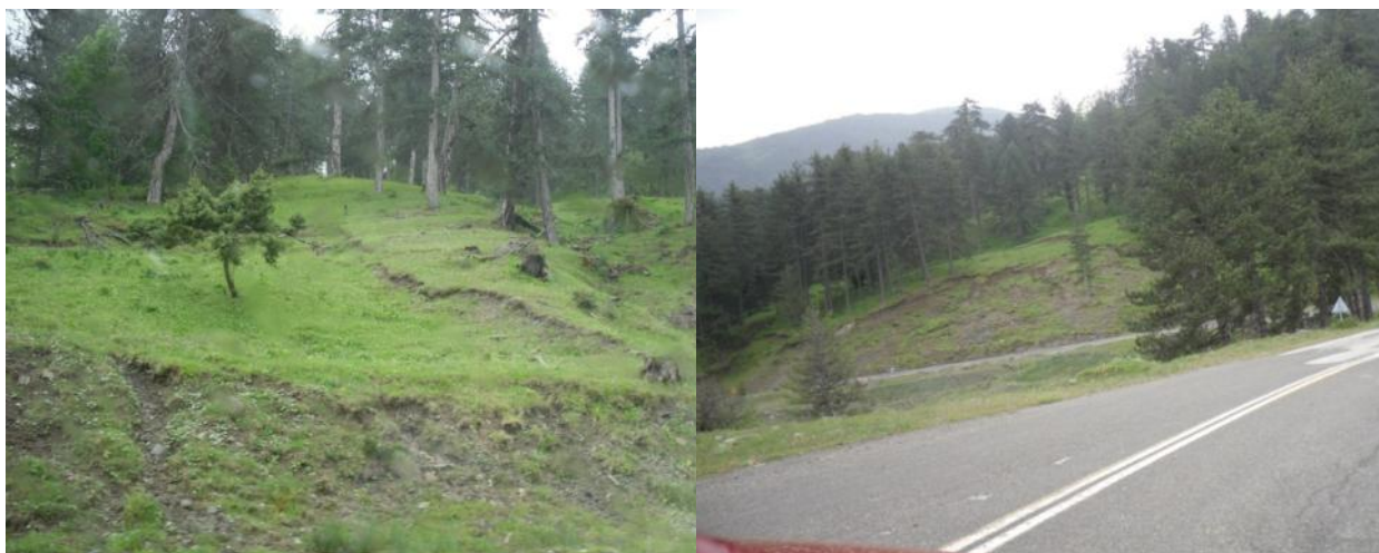
Εικόνα 5.25 Εδαφικά εξάρματα και Εικόνα 5.26 Αστοχία στο πρανές, θέση 20 εφελκυστικές ρωγμές στο πρανές, θέση 20
