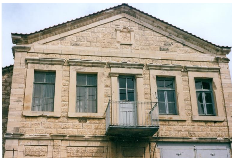
Σχήμα 4.2. Φωτογραφία οικίας Χ.Β. Τερζόγλου 1910, κτισμένη με ζεολιθικό τόφφο του Γουρουνορέματος Μεταξάδων-Αβδέλλας του Νομού Έβρου (Φιλιππίδης 2011).
