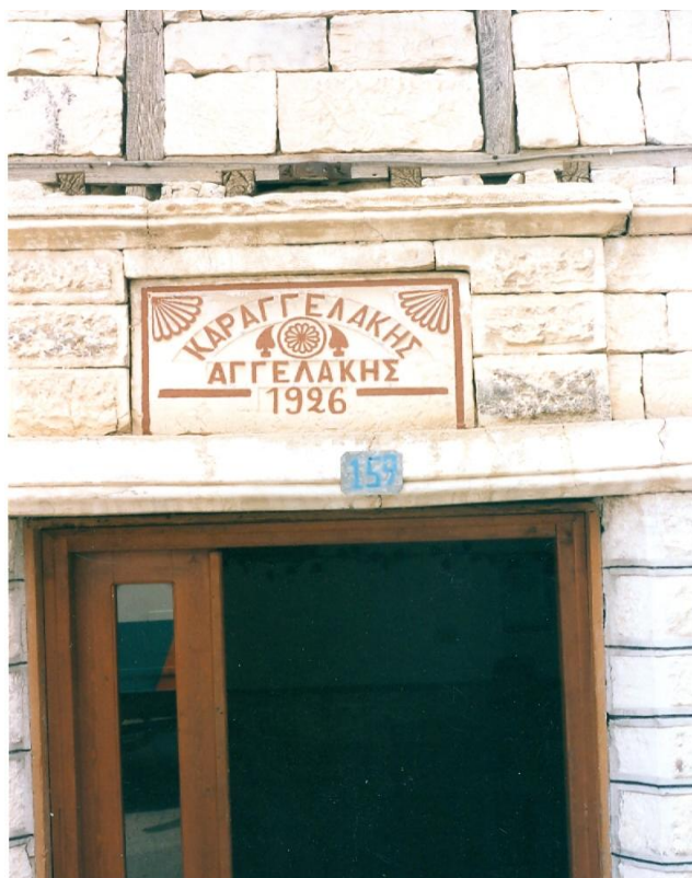
Σχήμα 4.4. Φωτογραφία καφενείου «ΚΑΡΑΓΓΕΛΑΚΗΣ ΑΓΓΕΛΑΚΗΣ 1926», κτισμένη με ξεολιθικό τόφφο του Γουρουνορέματος Μεταξάδων-Αβδέλλας του Νομού Έβρου (Φιλιππίδης 2011).
