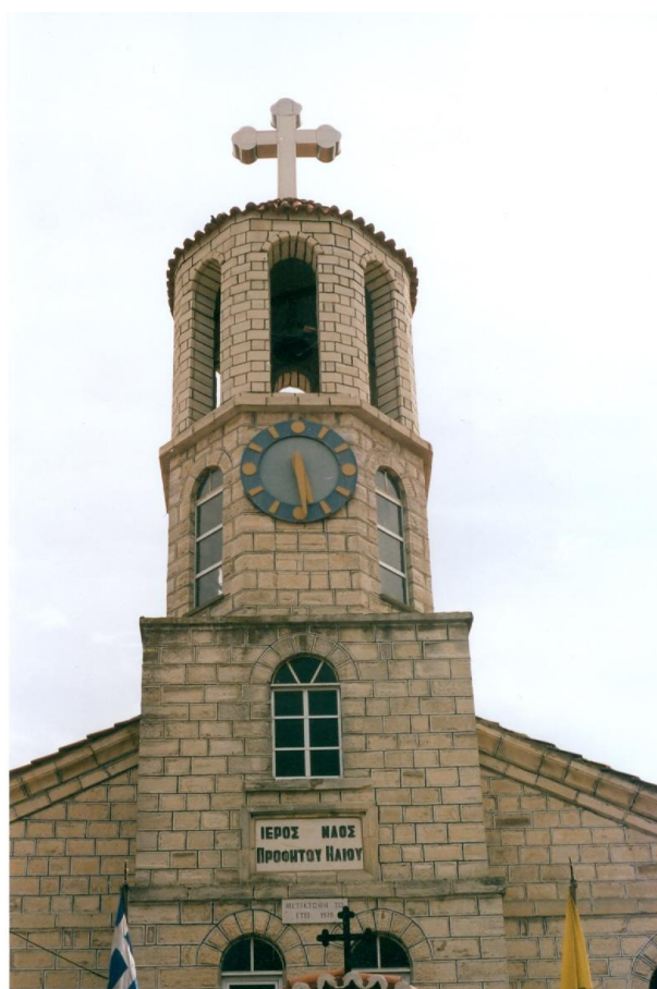
Σχήμα 4.3. Φωτογραφία Ιερού Ναού Προφήτη Ηλία 1939, κτισμένη με ζεολιθικό τόφφο του Γουρουνορέματος Μεταξάδων-Αβδέλλας του Νομού Έβρου (Φιλιππίδης 2011).
