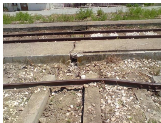
Σχήμα 2.3.4.1. Κάτω Αχαΐα: Ρωγμές στο οδόστρωμα γέφυρας (αριστερά), παραμορφώσεις σε σιδηροδρομικές γραμμές (δεξιά).
