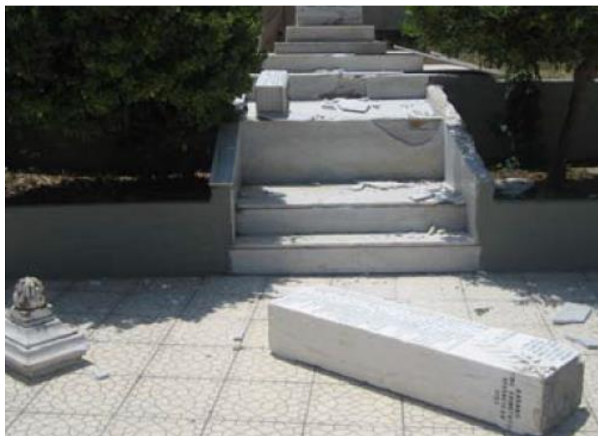
Σχήμα 2.3.2.6 Βραχναίικα: Μερική κατάρρευση τοιχοποιίας (πάνω), ανατροπή μαρμάρινου μνημείου (κάτω).
