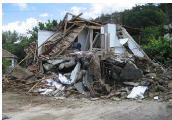
Σχήμα 2.3.2.4 Βάλμη: Ρηγματώσεις τοιχοποιών πλήρωσης σε κτίριο από Ο/Σ (πάνω), Ολικές καταρρεύσεις κτιρίων από φέρουσα λιθοδομή (κάτω).
