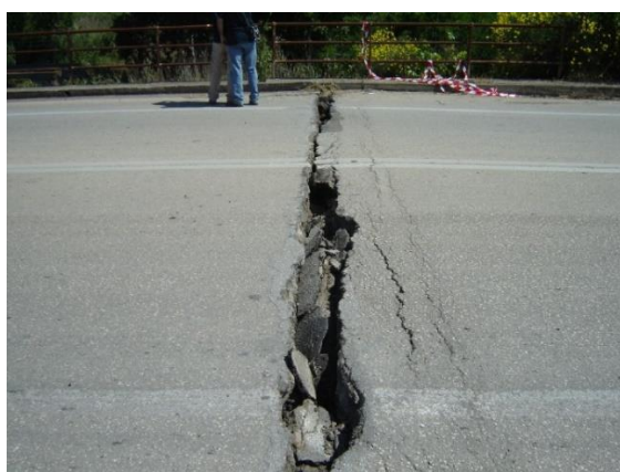
Σχήμα 2.3.4.1. Κάτω Αχαΐα: Ρωγμές στο οδόστρωμα γέφυρας (αριστερά), παραμορφώσεις σε σιδηροδρομικές γραμμές (δεξιά).
