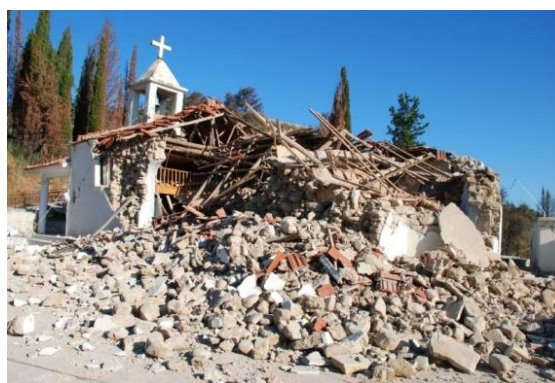
Σχήμα 2.3.2.4 Βάλμη: Ρηγματώσεις τοιχοποιών πλήρωσης σε κτίριο από Ο/Σ (πάνω), Ολικές καταρρεύσεις κτιρίων από φέρουσα λιθοδομή (κάτω).
