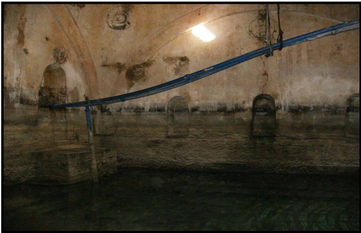
Εικόνα 5: Εσωτερικό παλιών λουτρών Τραϊανούπολης (Χάνες). Φαίνεται ο σωλήνας που μεταφέρει θερμό νερό
