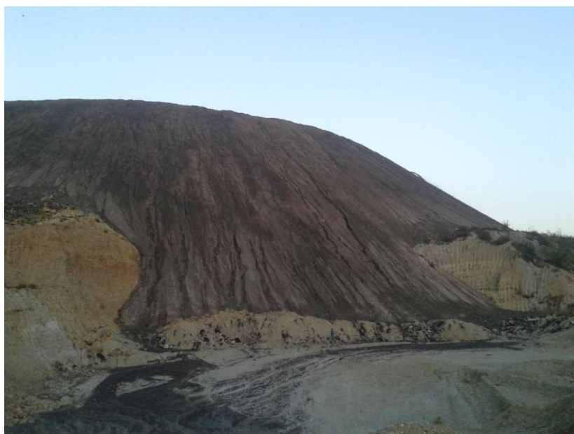
Σχήμα 32: Κατολίσθηση αποθέσεων της ΔΕΗ, που αποτέθηκαν πάνω στο σχηματισμό Προαστείου.
