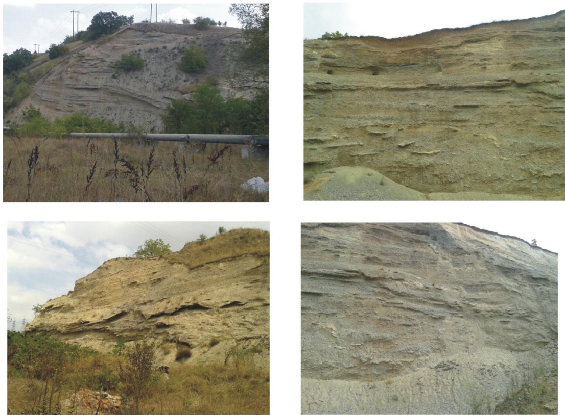
Σχήμα 18: Τεχνητό πρανές εμφάνισης του σχηματισμού Προαστείου λόγω διέλευσης αγωγού τηλεθέρμανσης.
