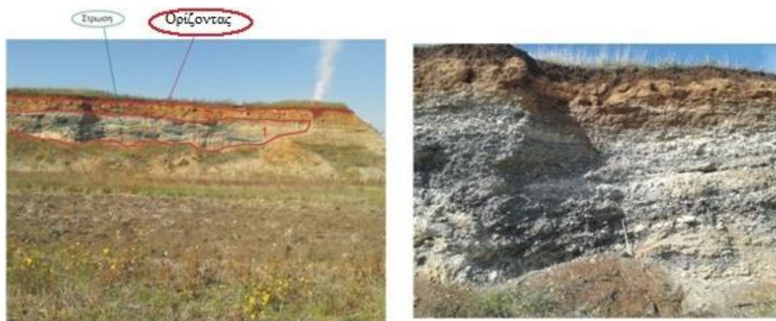
Σχήμα 24: Τεχνητό πρανές εμφάνισης σχηματισμού Προαστειου ύψους 4 μέτρων στη θέση AXEL-BP.
