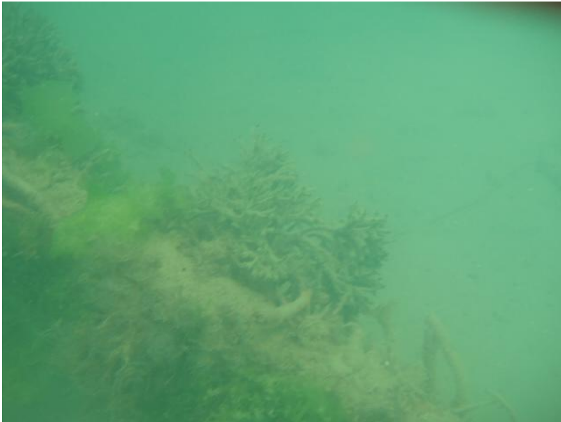
Φωτ. 7.18. Σωλήνα από πεσμένη πασσαλωτή μυδοκαλλιέργεια, με ανάπτυξη χλωρίδας στην επιφάνεια της.
