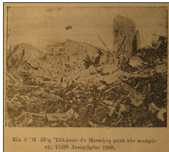
Εικόνα 72. Φωτογραφία από τις καταστροφές που προκάλεσε σεισμός στη Μεσσήνη.
