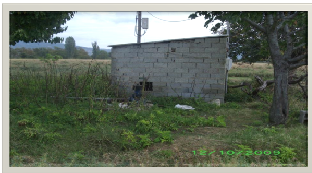
Σχήμα Γεώτρηση της περιοχής του Άνω Ανθεμούντα για αρδευτικούς σκοπούς.
