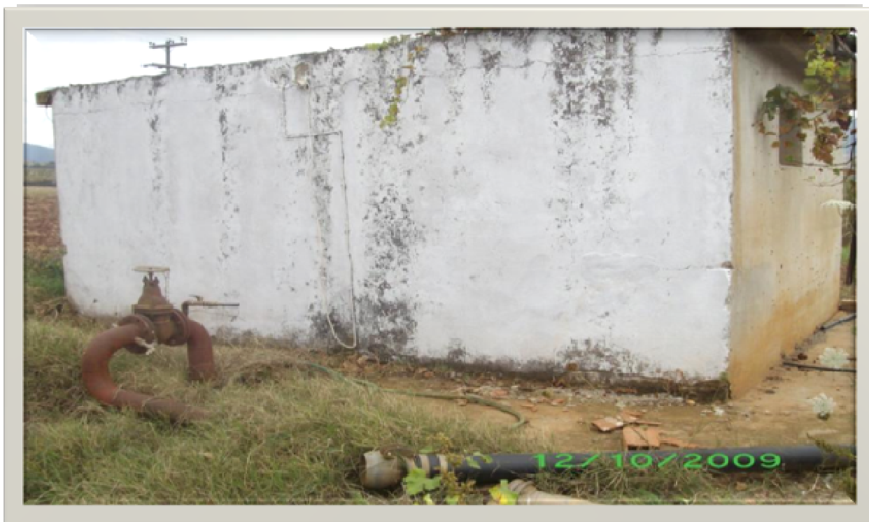
Σχήμα Γεώτρηση της περιοχής του Άνω Ανθεμούντα για αρδευτικούς σκοπούς.
