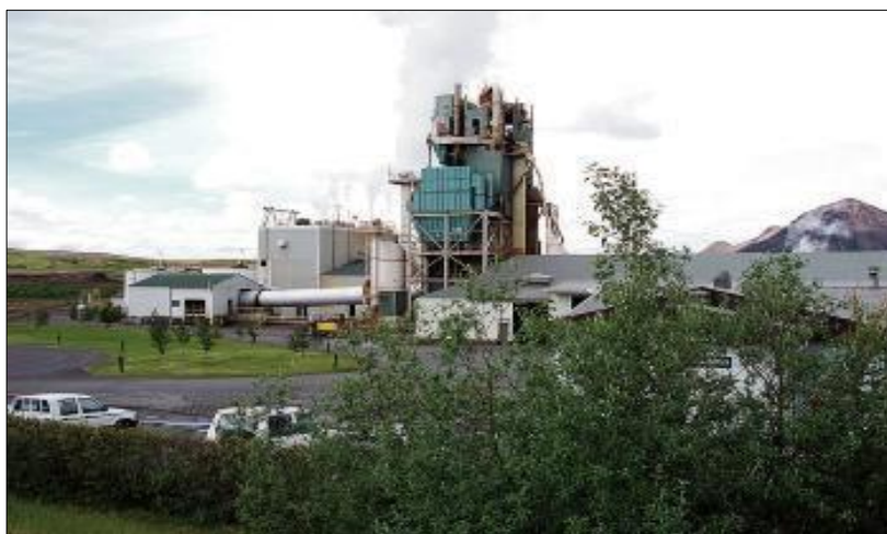
Εικόνα 23. Σύστημα υδροκυκλώνων, Βόρεια Ισλανδία ( https://www.facebook.com/photo.php?fbid=388688091168428&set=a.388688084501762.77260.388684387835465&type=1&theater ).
