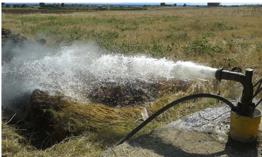
Εικόνα 1: Διαδικασία καθαρισμού της γεώτρησης AA-3Π με διάταξη air lift σε πλήρη εξέλιξη.
