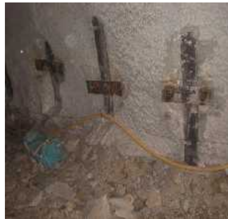
Εικόνα 19. Στήριξη των πλαισίων με την τοποθέτηση ζεύγους παθητικών αγκυρίων στη βάση τους (γραβάτα). (Μαρίνος Β. 2007).
