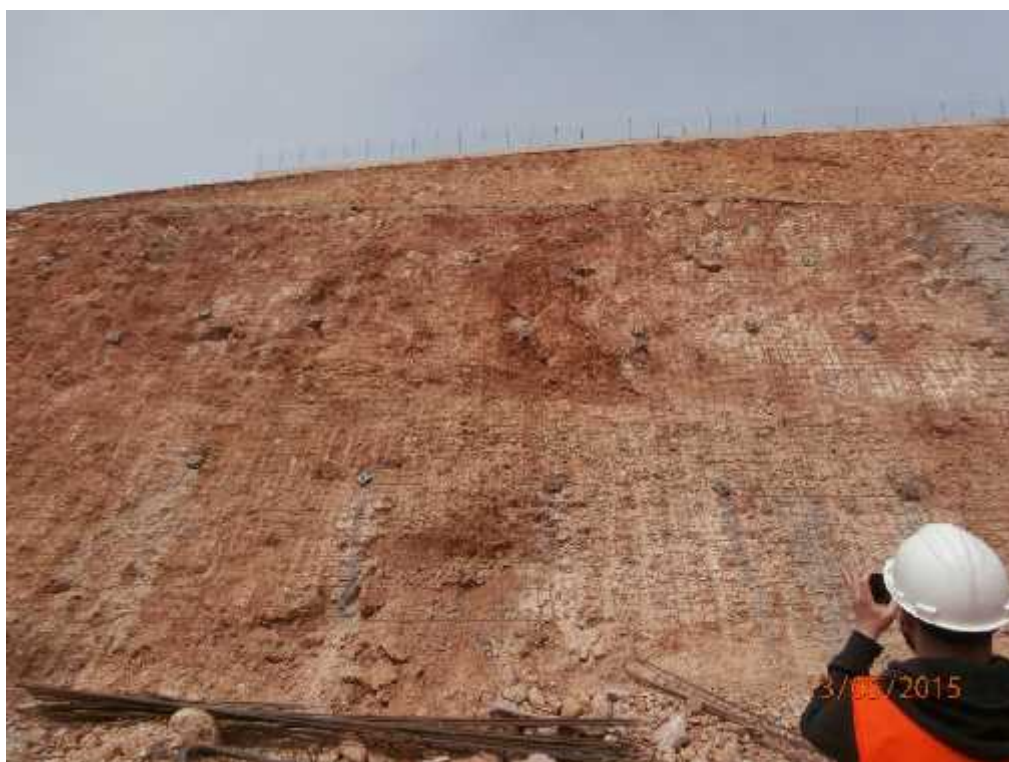
Εικόνα 98. Αντιστήριξη των πλευρικών πρανών με κάνναβο αγκυρίων και μεταλλικό πλέγμα.
