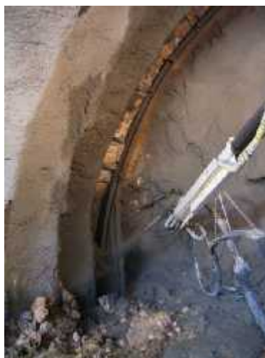
Εικόνα 15. Εκτοξευόμενο σκυρόδεμα. (Μαρίνος Β. 2007).
