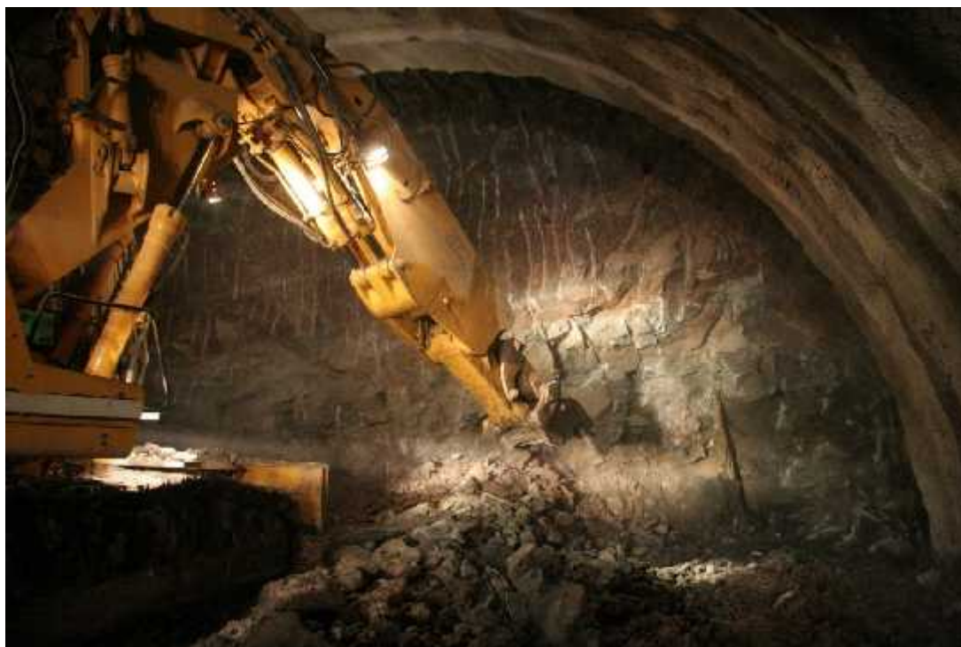
Εικόνα 3. Μηχανική εκσκαφή με "τσάπα". (Μαρίνος Β. 2007).
