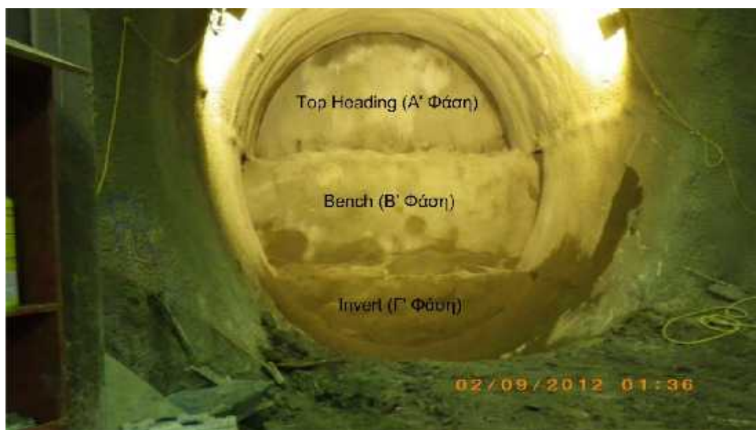
Εικόνα7. Οι φάσεις εκσκαφής. Top Heading, Bench and invert.
