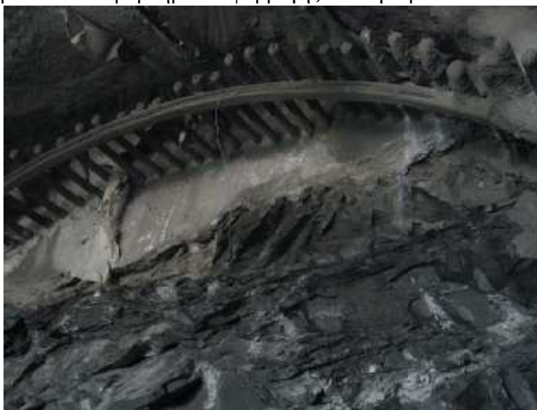
Εικόνα 24. Ελαφρά βλήτρα προπορείας (spiles). (Μαρίνος Β. 2007).
