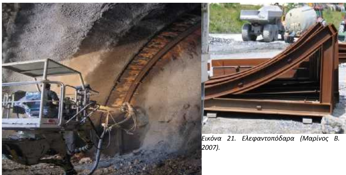
Εικόνα 20. Μεταλλικά πλαίσια τύπου HEB (Μαρίνος Β. 2007).
