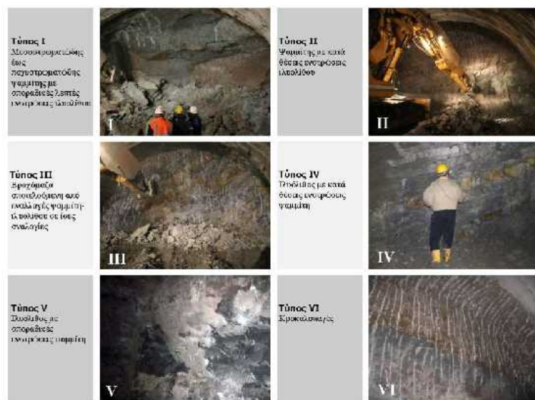
Εικόνα 32. Τεχνικογεωλογικοί τύποι μολασσικής βραχόμαζας (Μαρίνος Β. 2007).
