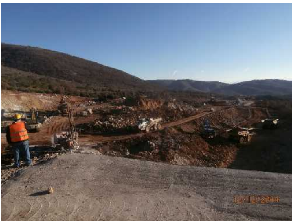
Εικόνα 99. Πανοραμική άποψη των εργασιών στα στόμια εισόδου.
