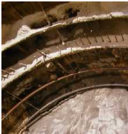
Εικόνα 18. Δοκοί σύνδεσης (Μαρίνος Β. 2007).
