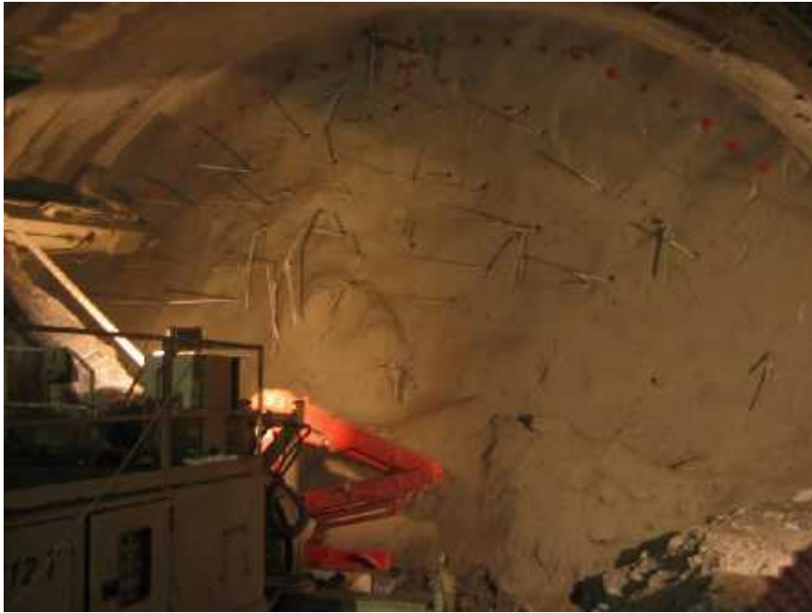
Εικόνα 26. Αγκύρια μετώπου-κυρίως υαλόκαρφα (fiberglass). (Μαρίνος Β. 2007).
