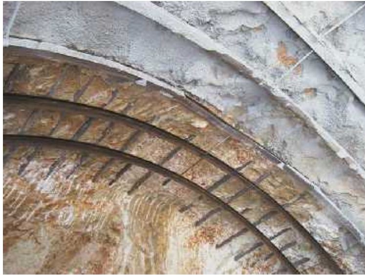
Εικόνα 17. Μεταλλικά πλαίσια (Μαρίνος Β. 2007).
