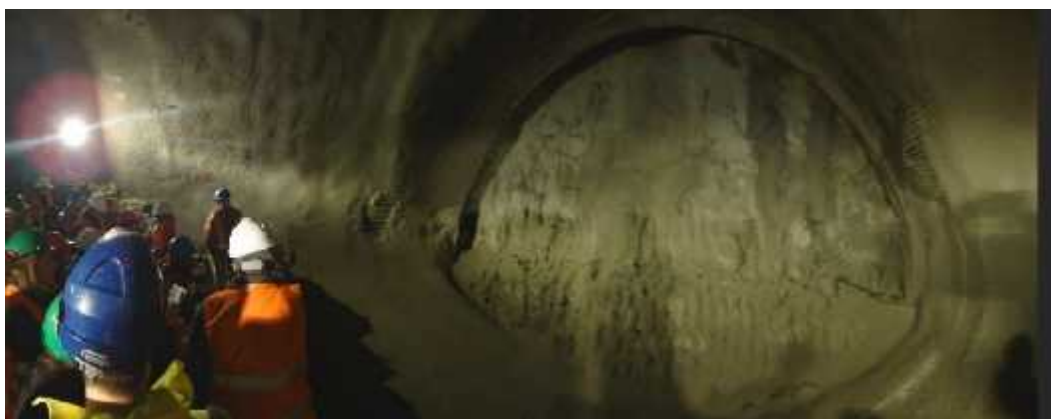
Εικόνα 27. Κλείσιμο του κελύφους της Α΄ Φάσης εκσκαφής με ινοπλισμένο σκυρόδεμα σε μορφή ανάστροφου τόξου σε περίπτωση έντονων παραμορφώσεων. (Μαρίνος Β. 2007).
