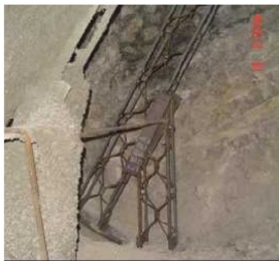
Εικόνα 23. Διεύρυνση δικτυωτού πλαισίου στη θέση θεμελίωσης του κελύφους (Μαρίνος Β. 2007).
