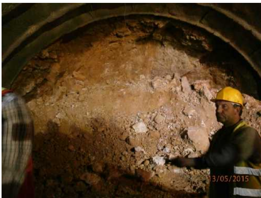
Εικόνα 100. Μέτωπο αριστερού κλάδου μετά από έκρηξη.
