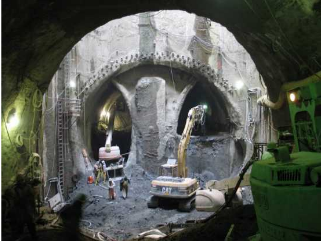
Εικόνα 8. Κατασκευή πλευρικών στοών (sidewall drifts) σε σήραγγα με μεγάλη διατομή.
