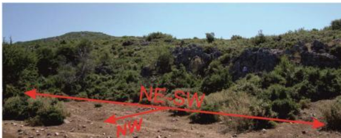
Φωτογραφία 20: Ρήγμα στους Ασβεστόλιθους Παντοκράτορα (Ji.k) (αναφέρεται ως F p _19). Η επιφάνεια του ρήγματος είναι απότομη και έντονα διαβρωμένη (x/y: 185.013/4.362.330, Greek Grid).
