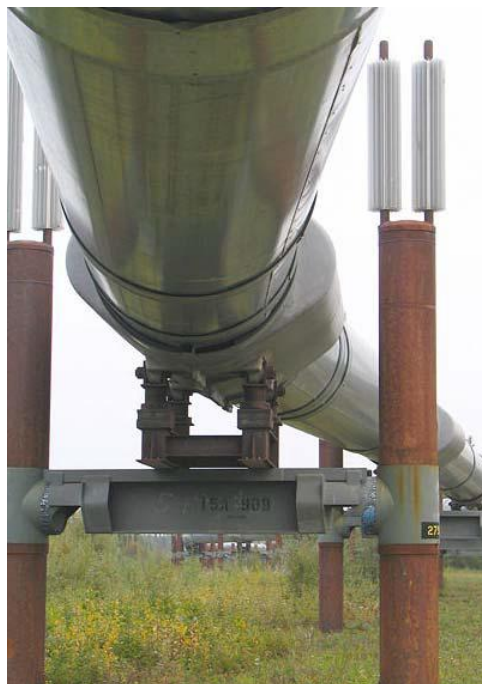
Σχήμα 4.7: Στηριξείς ολίσθησης.
