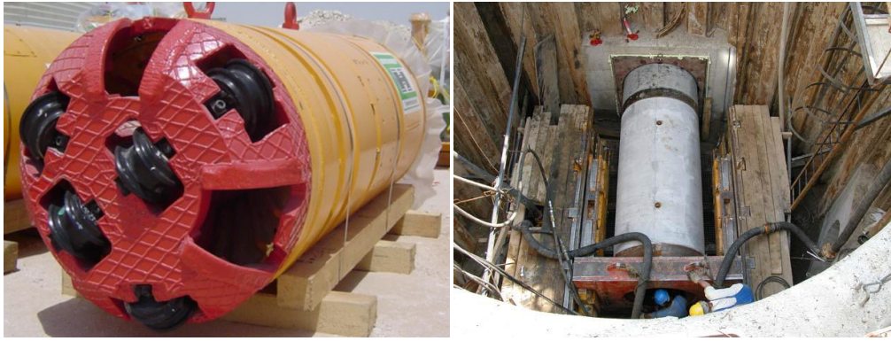
Σχήμα 4.18: Ειδική τηλεκατευθυνόμενη μηχανή (MTBM) και φρεάτιο διάτρησης για κατασκευή μικροσήραγγας.
