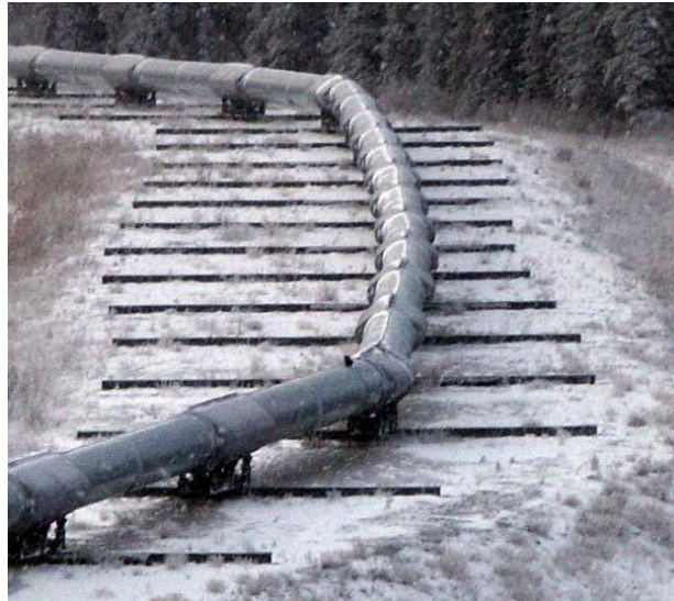
Σχήμα 4.6: Αγωγός πάνω από το έδαφος στην Αλάσκα που περνάει πάνω από το Denali Fault.
