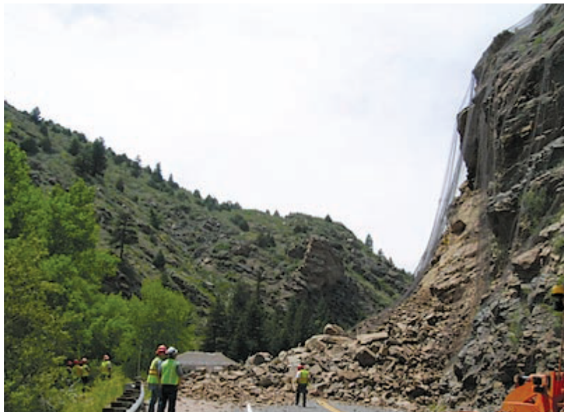
Εικόνα 1.3: Μια πτώση βράχου / ολίσθηση που συνέβη στο Κολοράντο των Ηνωμένων Πολιτειών, της Αμερικής, το 2005, κλείνοντας την κυκλοφορία για αρκετές εβδομάδες. Η φωτογραφία δείχνει επίσης ένα παράδειγμα βραχοκουρτίνας, ένα εμπόδιο που συνήθως εφαρμόζεται πάνω από ασταθείς βραχώμαζες. (Highland & Bobrowsky, 2008)
