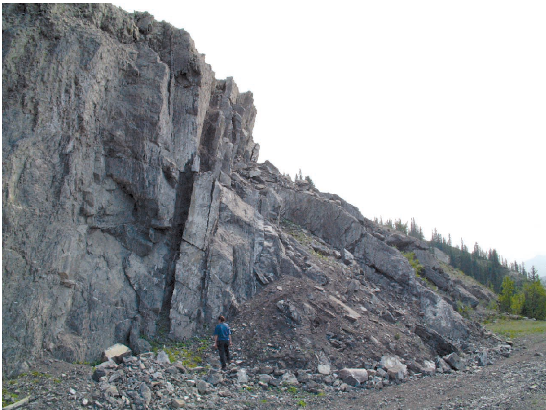
Εικόνα 1.5: Ανατροπή στο FortSt. John του Καναδά (Highland & Bobrowsky, 2008)
