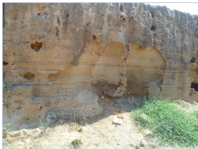
ΕΙΚΟΝΑ3.30: Κυψελοειδής φθορά λόγω ανέμων οι οποίοι μεταφέρουν στα σταγονίδια με υψηλή περιεκτικότητα σε άλατα Λατομείο 3
