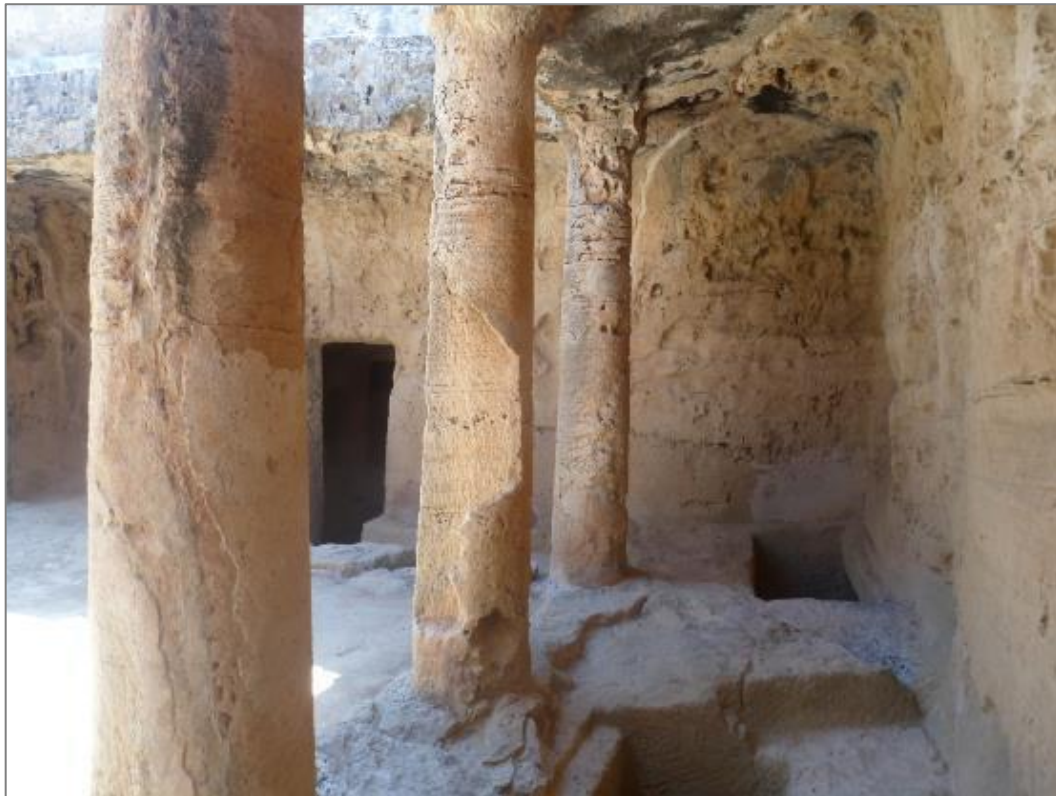
ΕΙΚΟΝΑ 3.37: Οριστική απώλεια τμήματος της κολώνας αίθριο Τάφου 4
