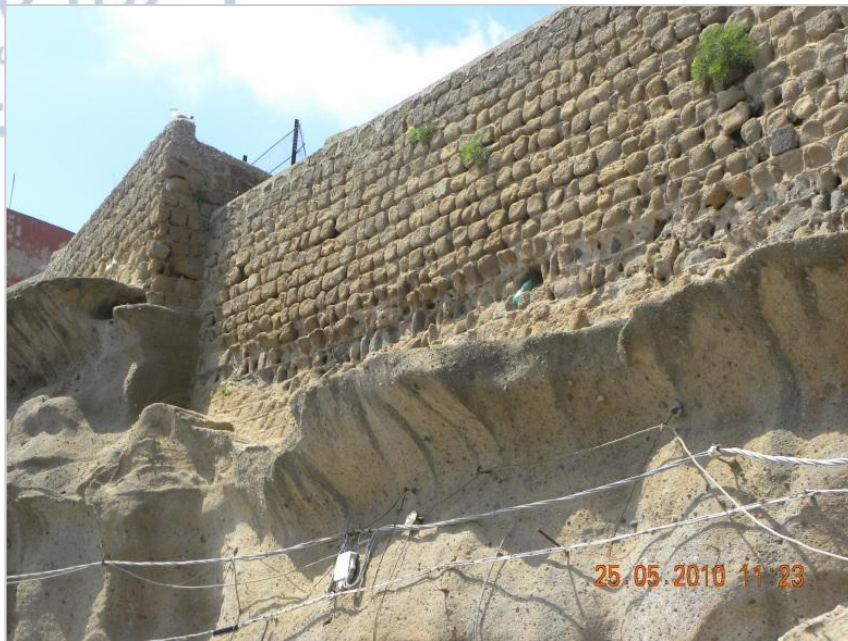
ΕΙΚΟΝΑ 10.98: Λιθόκτιστο τείχος του ρωμαϊκού λιμένα της νήσου Ventotene στην στέψη του πρανούς από τόφφους, πριν την εφαρμογή των έργων αποκατάστασης (Από Bosco et al. 2013).
