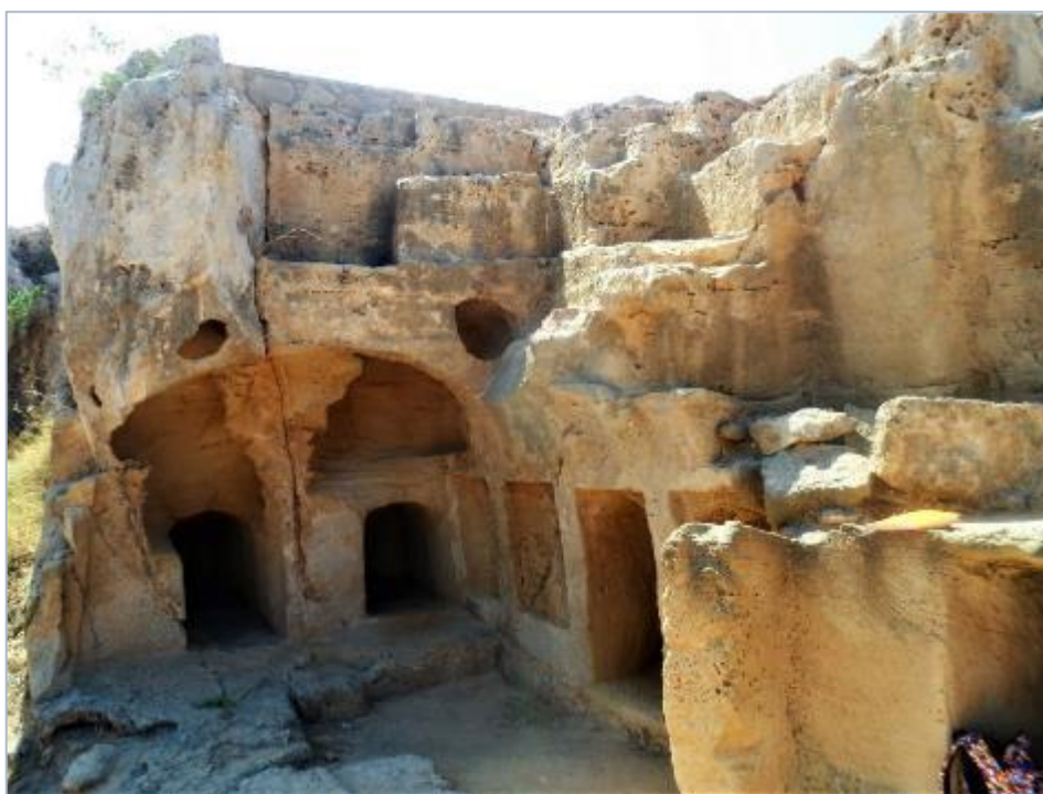
ΕΙΚΟΝΑ 2.18 : Απεικόνιση της εισόδου του Λατομείου 4, λήψη από την δυτική πλευρά. Διακρίνεται η έντονη λατόμευση καθώς και η αποκόλληση τεμάχους της δυτικής πλευράς στην είσοδο του Λατομείου
