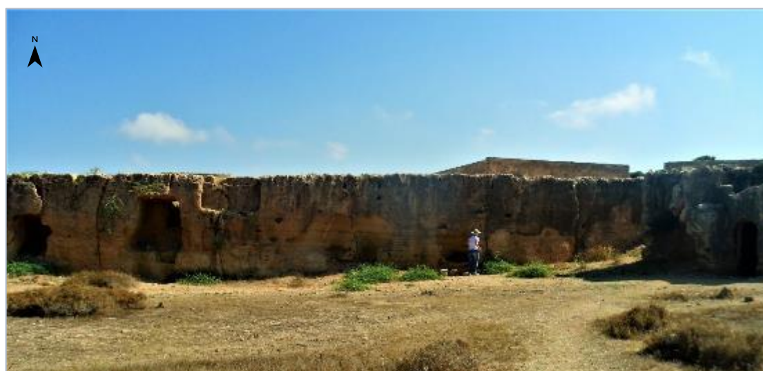
ΕΙΚΟΝΑ 2.10 : Τμήμα του βόρειου πρανούς στο Λατομείου 3 λήψη από την νότια πλευρά
