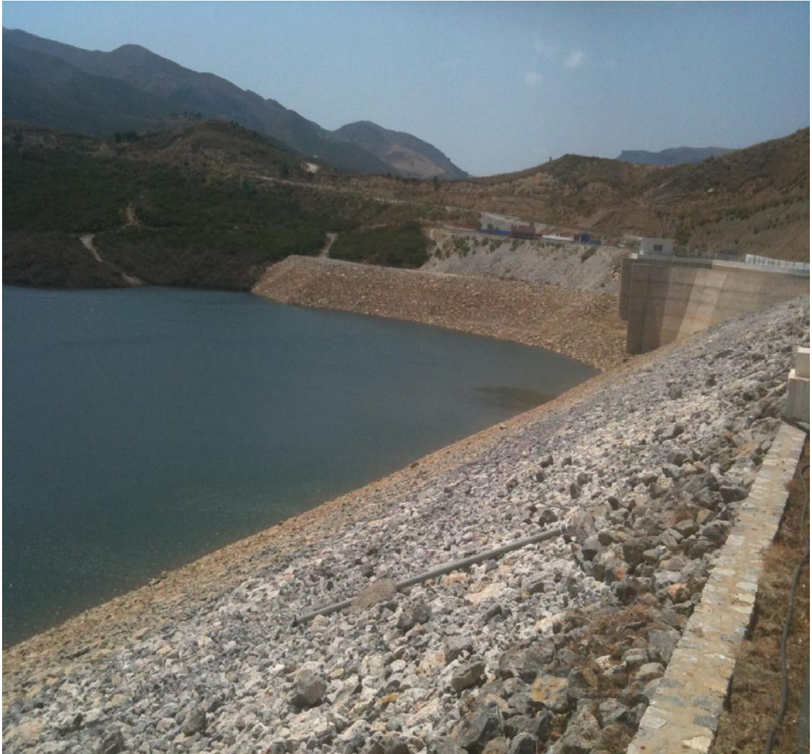
Άποψη του δεξιού πρανούς και του ταμιευτήρα του φράγματος.
