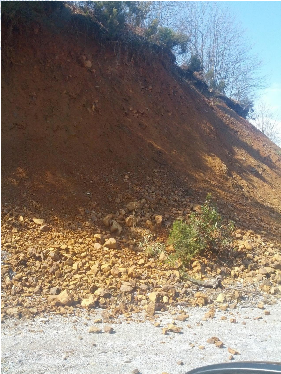
Εικόνα 26: Αμφιβολιτικοί σχιστόλιθοι όπως εμφανίζονται στην ευρύτερη περιοχή
