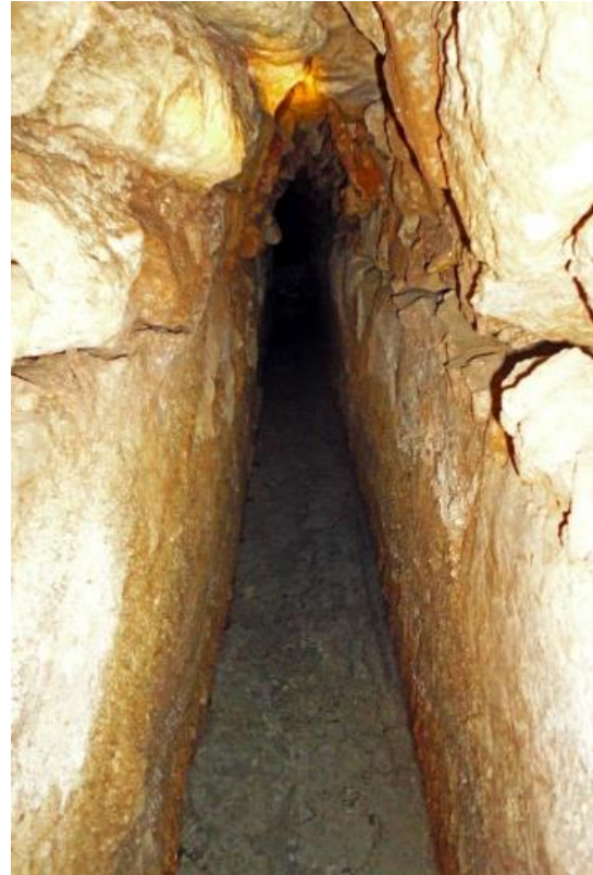
Σχήμα 24, 25. Η πετρόκτιστη οροφή του qanat Φώτο.: Βίκτορας Καραγιάννης
