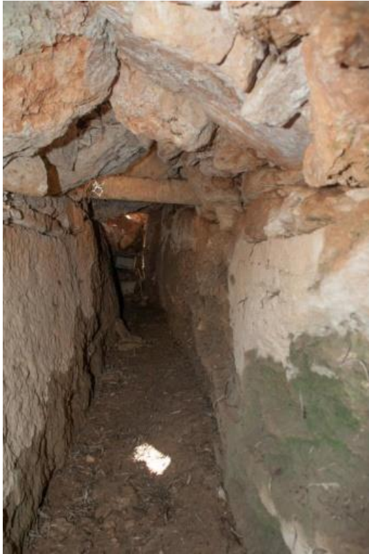
Σχήμα 24, 25. Η πετρόκτιστη οροφή του qanat Φώτο.: Βίκτορας Καραγιάννης
