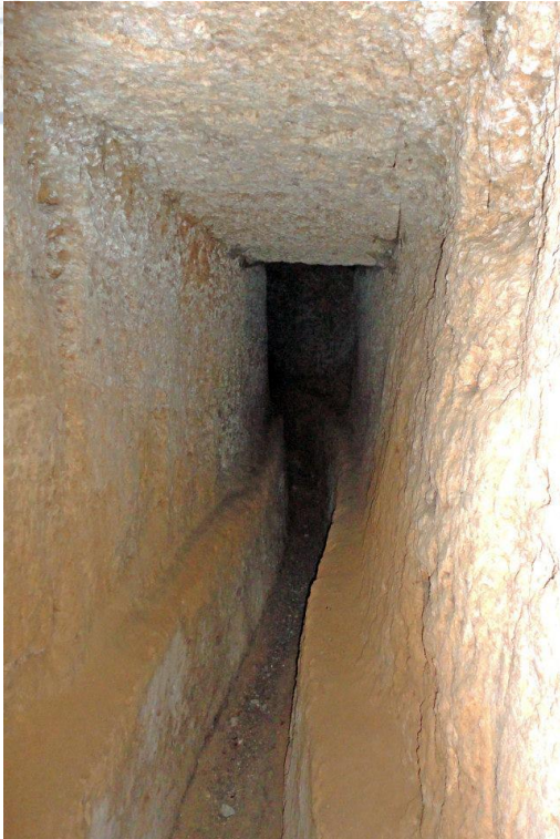
Σχήμα 26. Η οροφή χωρίς υποστήριξη Φώτο.: Βίκτορας Καραγιάννης
