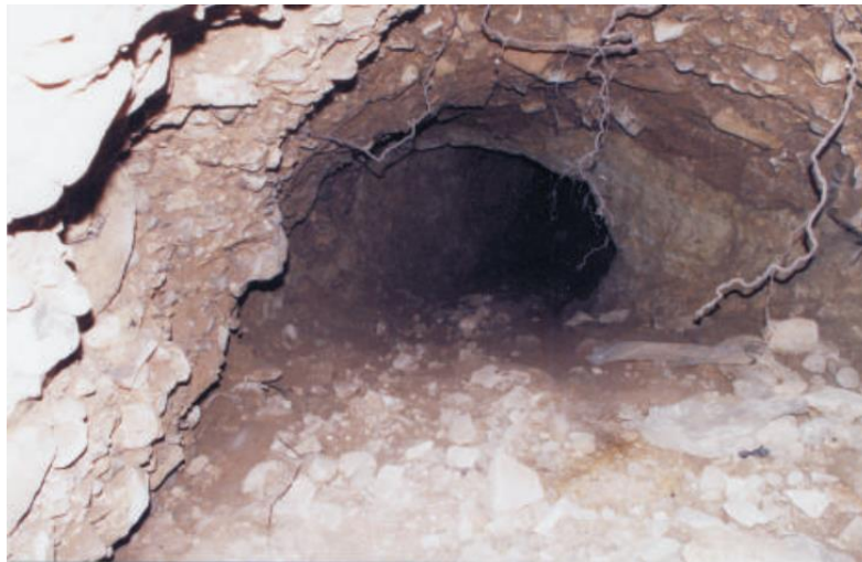
Σχήμα 18. Κατάρρευση τμήματος qanat. Πηγή: Υδατοπρομήθεια Λάρνακας 4000 Χρόνια Ιστορίας
