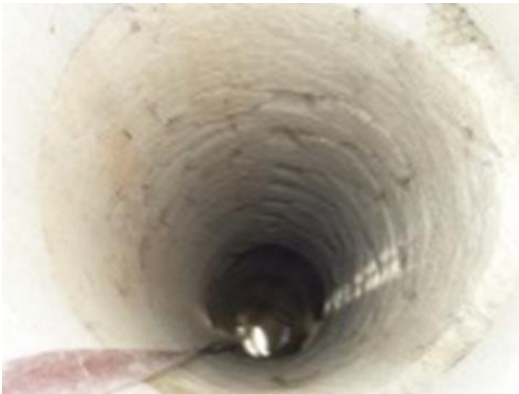
Σχήμα 34. Πετρόκτιστο πηγάδι του qanat
