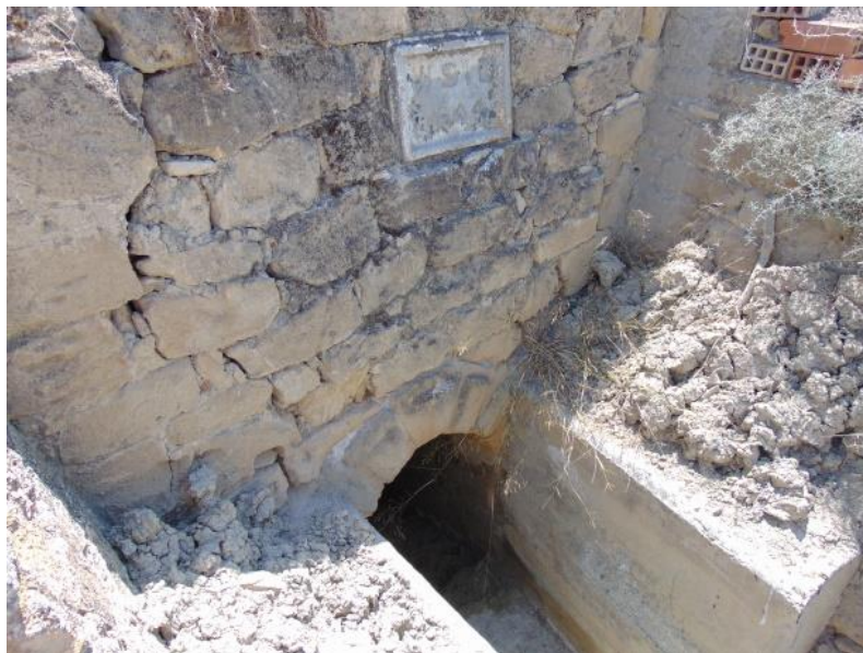
Σχήμα 37. Η έξοδος του qanat Τσερίου μαζί με την επιγραφή της χρονολογίας κατασκευής του.
