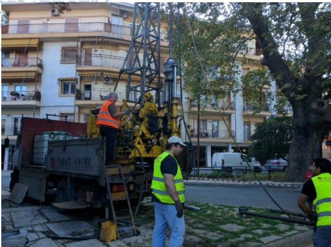
Εικόνα 3: Γεωτρητικές Εργασίες στον προαύλιο χώρο του μνημείου.
