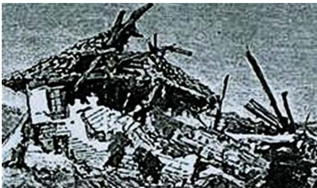
Εικόνα 3. Λεπτομέρεια της εικ.1 όπου φαίνεται ότι το σπίτι δεν κατέρρευσε εξαιτίας των δονήσεων αλλά από την ολίσθηση που πραγματοποιήθηκε πάνω στο χάσμα.
