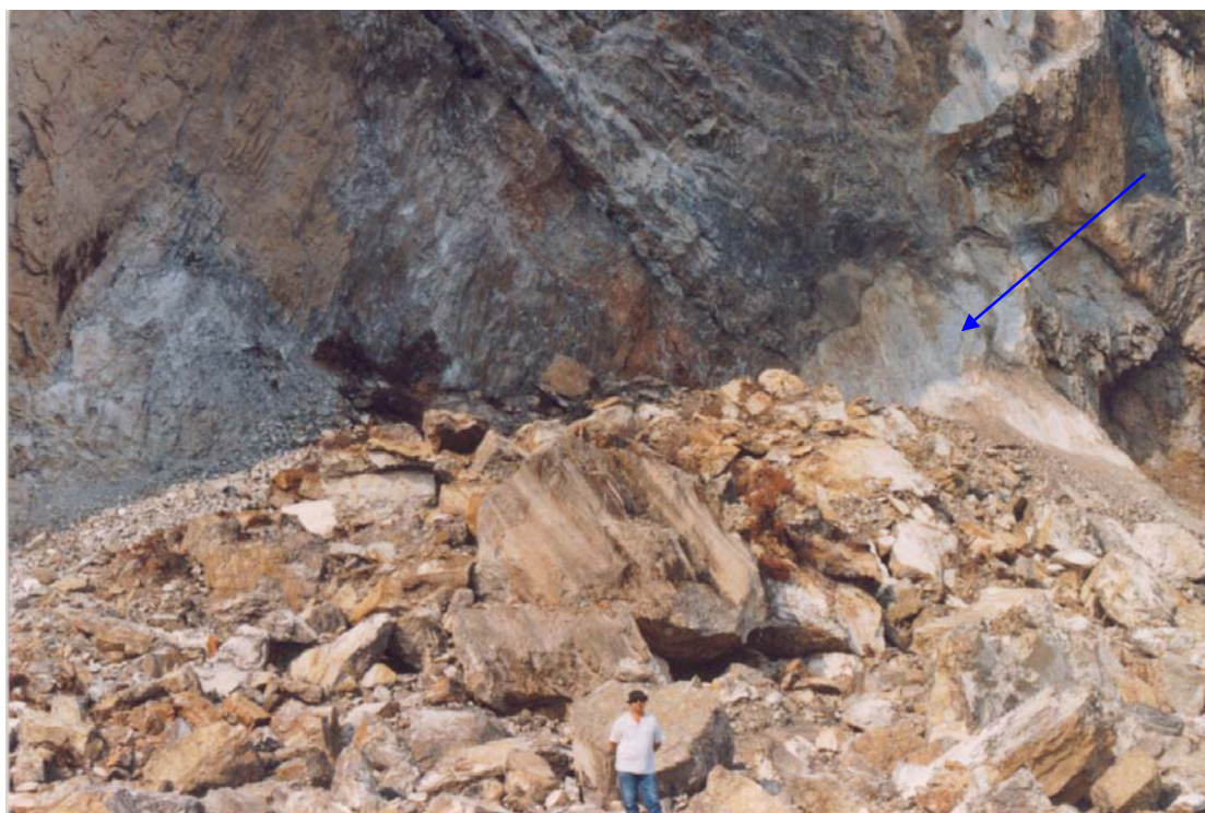
Φωτ.3 Εδώ απεικονίζεται η καινούργια επιφάνεια που αποκαλύφθηκε(μπλε βέλος) (μάλλον μετά από την χρήση εκρηκτικών που χρησιμοποιήθηκαν ώστε να μειωθούν οι κίνδυνοι για το κτίριο που χτίστηκε στην βάση του).
