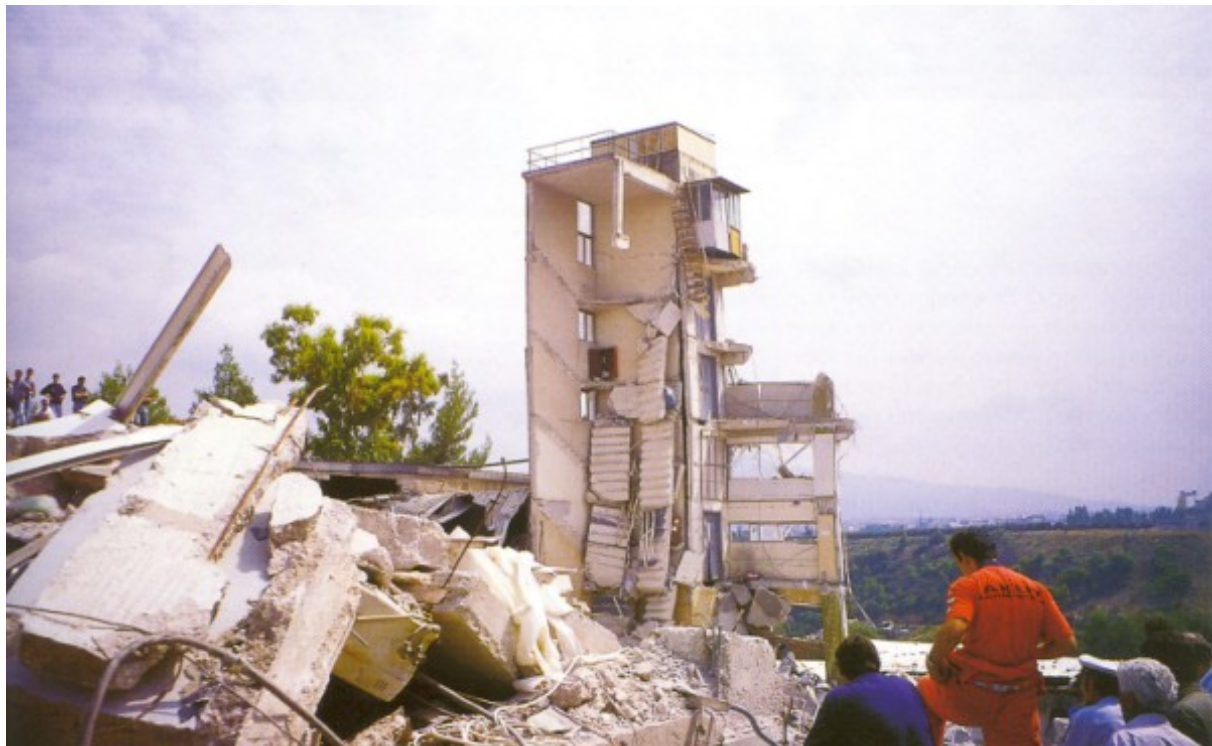
Φωτ. 2.2. Το κτίριο της Ricomex, στις όχθες του Κηφισού, το οποίο κατέρρευσε στον σεισμό της Αθήνας. Με την κόκκινη στολή διακρίνεται μέλος του τουρκικού συνεργείου έρευνας & διάσωσης AKUT. (Πηγή: ΟΑΣΠ).
