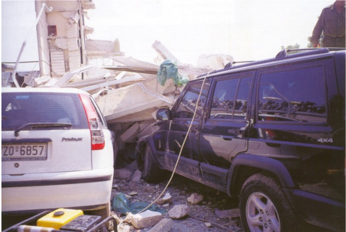
Φωτ. 2.1. Αθήνα, Σεπτέμβριος 1999. Αυτοκίνητα καταπλακωμένα από κτίριο που κατέρρευσε. (Πηγή:ΟΑΣΠ)
