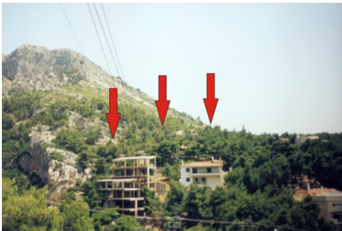
Φωτ. 3.8. Πανοραμική άποψη προς ΒΑ, από τη θέση N14. Με τα βέλη σημειώνεται το ίχνος του ρήγματος, το οποίο είναι ευδιάκριτο από την έντονη μεταβολή της μορφολογικής κλίσης.
