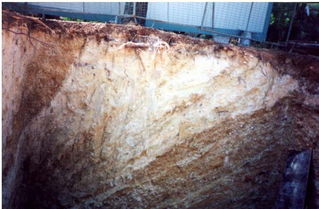
Φωτ. 3.5. Εμφάνιση των Ανωμειοκαινικών στρωμάτων σε εκσκαφή οικοδομής στο δήμο Θρακομακεδόνων (Γωνία Μεγάλου Αλεξάνδρου και Μακεδονομάχων – θέση G2). Τα στρώματα κλίνουν προς ΝΑ με 30°.
