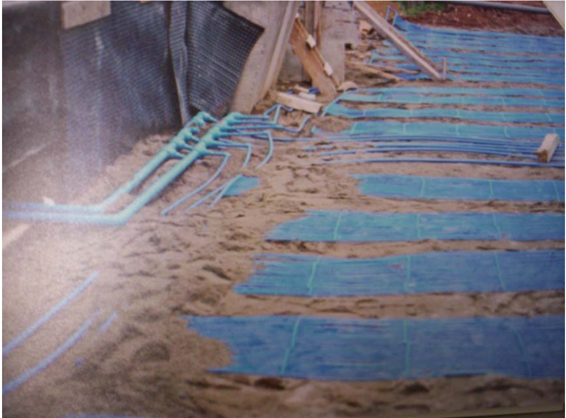
Γεωεναλλάκτης οριζόντιου τύπου
