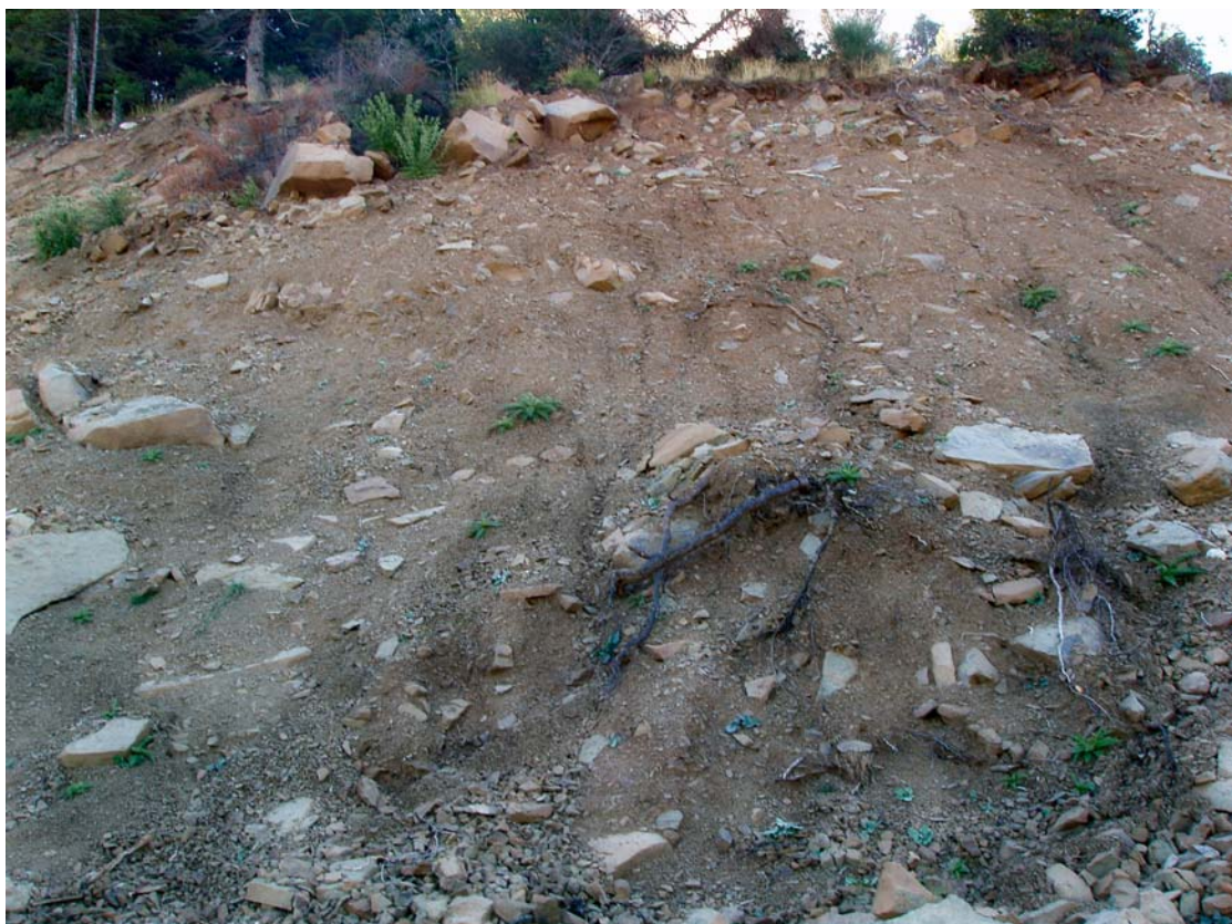
Αποψη σχηματισμών βόρεια της κατολίσθησης.
