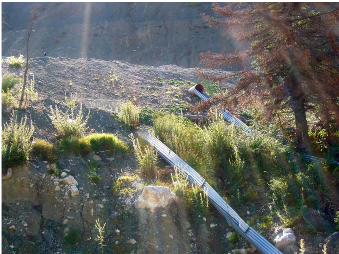
Η κατασκευαζόμενη επενδεδυμένη τάφρος για την απαγωγή των υδάτων από το υπάρχον τεχνικό.
