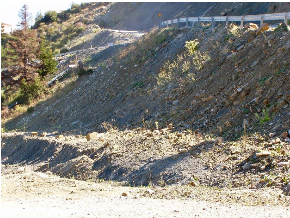
Άποψη σχηματισμών κατάντη της Εθνικής Οδού.
