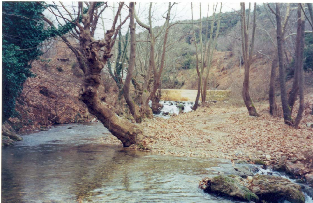
Φωτογραφία 13 : Σημείο υδρομάστευσης (στο βάθος) για αρδευτικούς σκοπούς.
