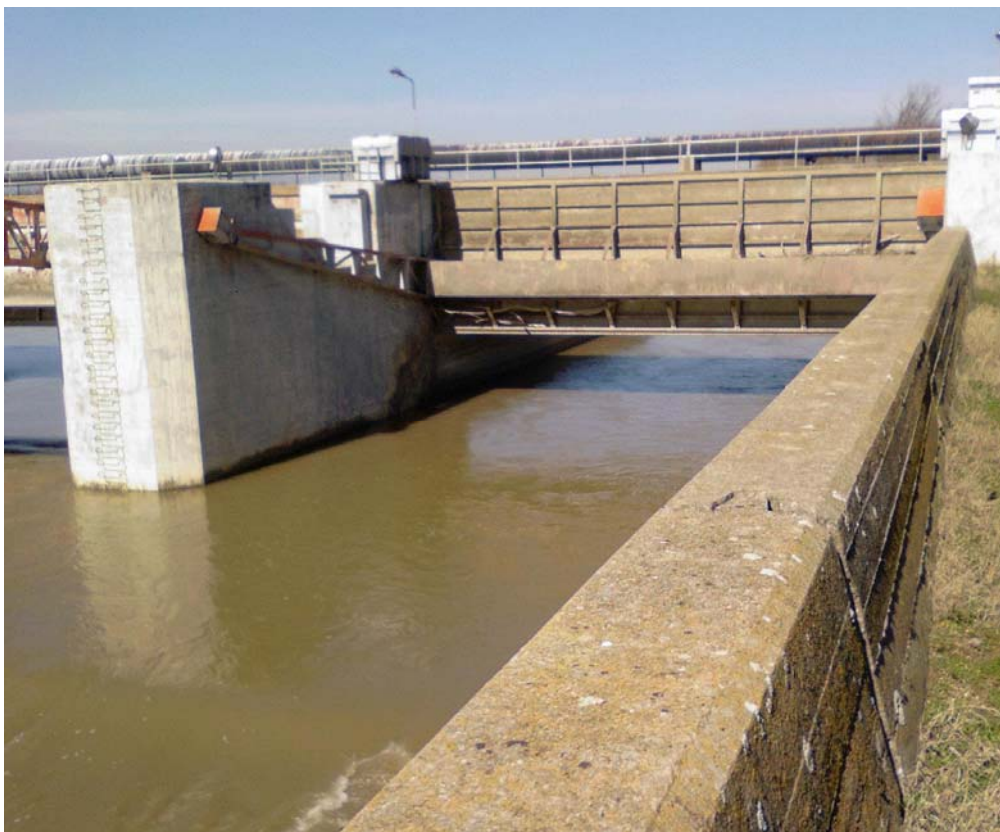
Σχήμα 3.3: Φωτογραφία του τέταρτου θυροφράγματος το οποίο χρησιμοποιείται περισσότερο ως ρυθμιστής της στάθμης.
