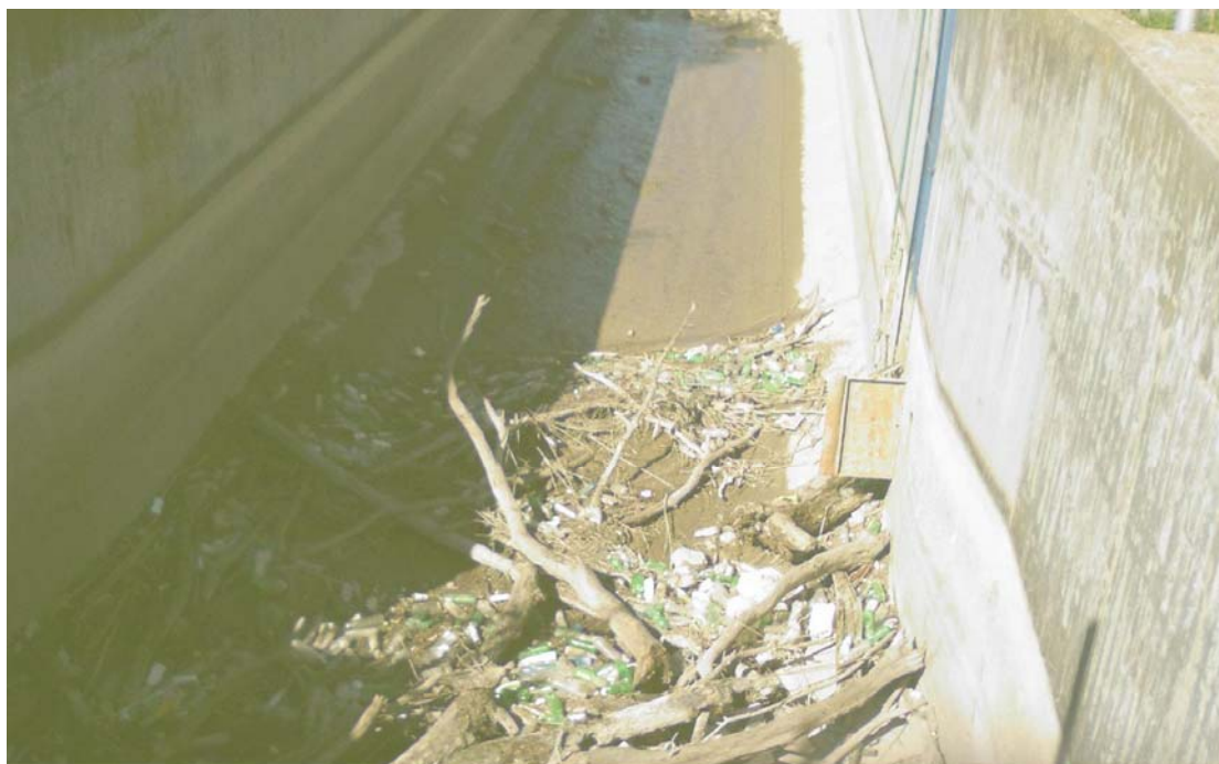
Σχήμα 5.1: Φερτό υλικό συγκεντρωμένο σε αρδευτική διώρυγα του ΓΟΕΒ
