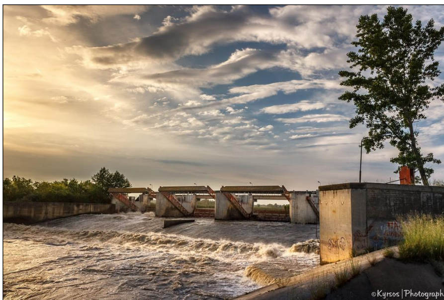
Σχήμα 1.4: Το φράγμα της Έλλης κοντά στο χωριό Γέφυρα
