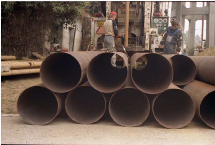
Εικόνα 24 . Περιφραγματικοί σωλήνες διαμέτρου 16 ιντσών και πάχους 5 mm που χρησιμοποιήθηκαν για τα 52 πρώτα μέτρα της υδρογεώτρησης.
