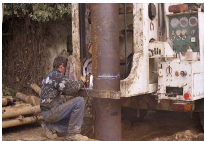
Εικόνα 25 . Σύνδεση των περιφραγματικών σωλήνων με ηλεκτροσυγκόλληση
