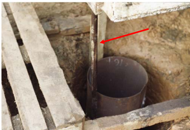
Εικόνα 26 . Σωλήνας που εισάγει αέρα μέσα στην οπή.
