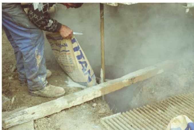
Εικόνα 27 . Εισαγωγή τσιμέντου στην οπή της υδρογεώτρησης.
