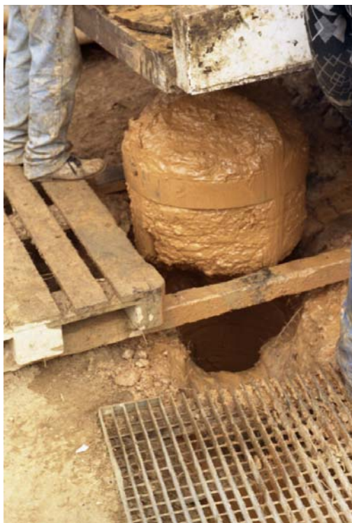
Εικόνα 23 . Διεύρυνση της οπής της γεώτρησης Τρίφτερο , διαμέτρου 24 ιντσών
