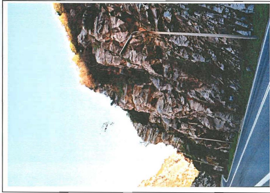
Φωτ.5. Πρανές με πολύ ισχυρή κλίση και μεγάλο ύψος. Το πέτρωμα είναι πυκνά διερρηγμένο και τα κύρια επίπεδα ασυνεχειών έχουν δυσμενή προσανατολισμό προς το πρανές και μεγάλη κλίση. Στο ανάντη πρανές (δεξιά) οι βραχώδεις μάζες είναι έντονα χαλαρωμένες και με σημαντικής έκτασης υποσκαφές κατά μήκος ασυνεχειών που διατέμνουν εγκάρσια τα ομόρροπα προς το πρανές επίπεδα ασυνεχείας.
