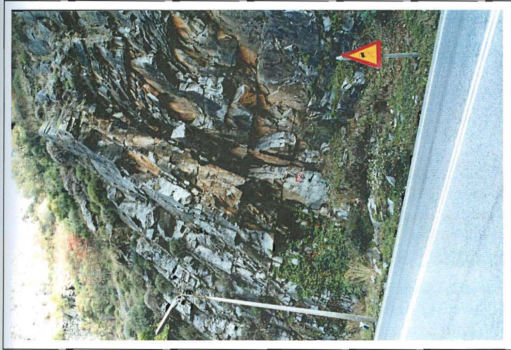
Φωτ.6. Διακρίνεται η σημαντική διάρρηξη του πετρώματος από πυκνό δίκτυο παράλληλων ασυνεχειών αρκετά διευρυμένες και με μικρή απόσταση μεταξύ τους. Τα ομόρροπα προς το πρανές επίπεδα ασυνέχειας διατέμνονται από παράλληλες ασυνέχειες κατά μήκος των οποίων δημιουργούνται σημαντικές υποσκαφές. Το ανάντη οπιστή προανέξ εφέλιπασται με ήπιον κλίση
