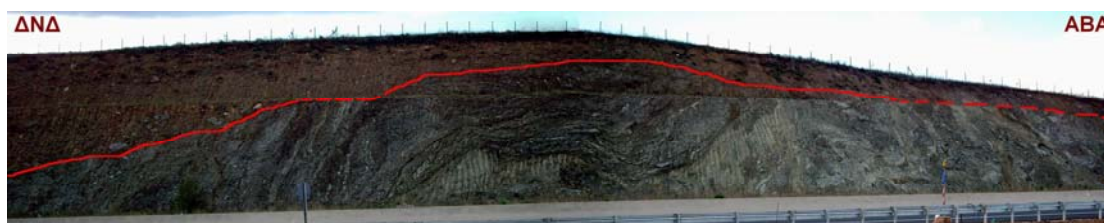
Σχ. 1.1.3 Πάνω από την κόκκινη γραμμή φαίνονται τα οφιολιθικά κροκαλοπαγή, ενώ δεξιά οι πτυχωμένοι οφιοίλιθοι στη ζώνη του ρήγματος Ταξιάρχη (κατά μήκος της Εγνατίας Οδού στο τμήμα Γρεβενών - Κοζάνης, μετά τη σήραγγα).
