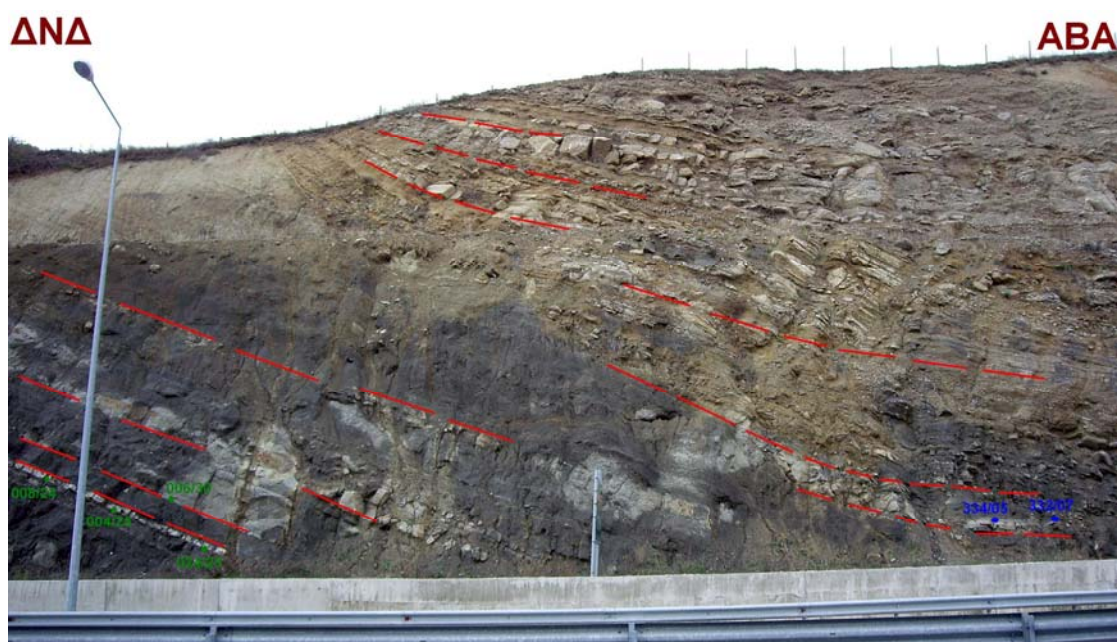
Σχ. 3.5.1 Τμήμα των υποκείμενων στρωμάτων, όπου αριστερά διακρίνονται αυτά με τις μεγαλύτερες κλίσεις και δεξιά η σημαντική ελάττωσή τους.
