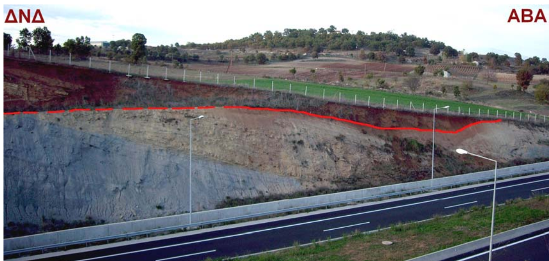
Σχ. 1.1.2 Κάτω από την κόκκινη γραμμή διακρίνονται τα μολασσικά ιζήματα σειράς Τσοτυλίου, της Μεσοελληνικής αύλακας. Πάνω από αυτή φαίνονται οι Πλειο-Πλειστοκαινικές αποθέσεις ερυθρού χρώματος και το ρηχό σύγκλινο που δημιουργείται (κατά μήκος της Εγνατίας Οδού στο τμήμα Γρεβενών - Κοζάνης, πριν τη σήραγγα, κοντά στο χωριό Ταξιάρχη).
