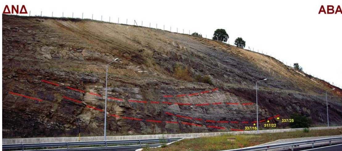
Σχ. 3.5.3. Τμήμα της τομής, όπου φαίνεται η βύθιση των υποκείμενων στρωμάτων (ΒΔ) και η κλίση τους ( 15^{\circ} - 25^{\circ} ) κοντά στην ασυμφωνία και η βύθιση των υπερκείμενων προς ΒΑ (δεξιά της ασυμφωνίας).
