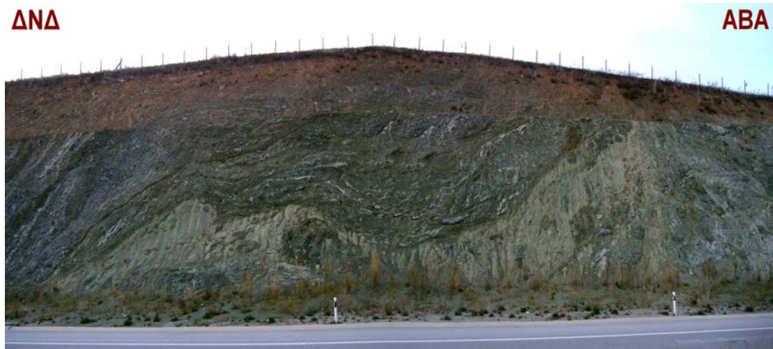
Σχ. 3.5.6. Πτυχωμένα οφιολιθικά πετρώματα στη ζώνη του ρήγματος Ταξιάρχη δυτικά της σήραγγας.
