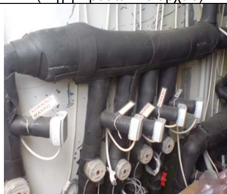
Γενική εσωτερική άποψη του χώρου της αντλίας θερμότητας - διάφορες συνδέσεις (Πηγή:Προσωπικό αρχείο)
