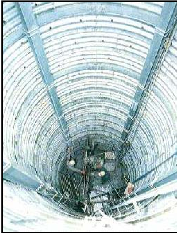
Σχήμα 6.8. Εσωτερικό φρεατίου αποστράγγισης μεγάλης διαμέτρου.
