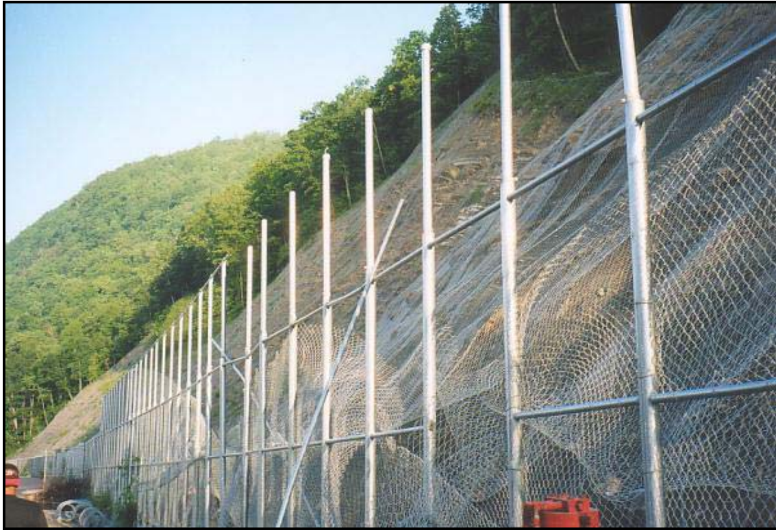
Σχήμα 8.7. Εφαρμογή συστήματος συρμάτινων πλεγμάτων για την προστασία από καταπτώσεις βραχωδών τεμαχών.
