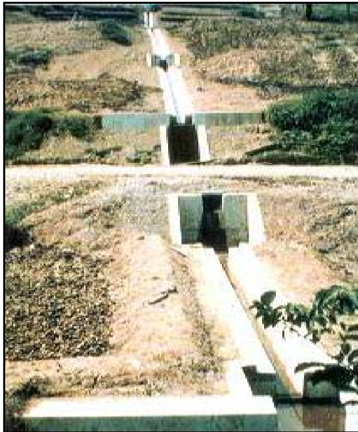
Σχήμα 6.4. Τάφροι επιφανειακής αποστράγγισης.
