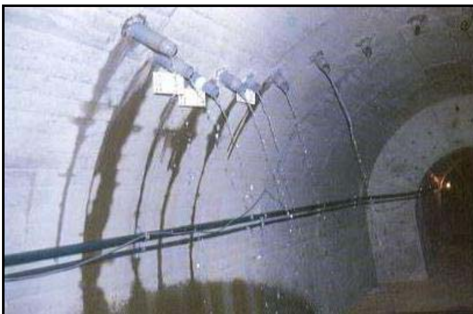
Σχήμα 6.12. Εσωτερικό αποστραγγιστικής στοάς.
