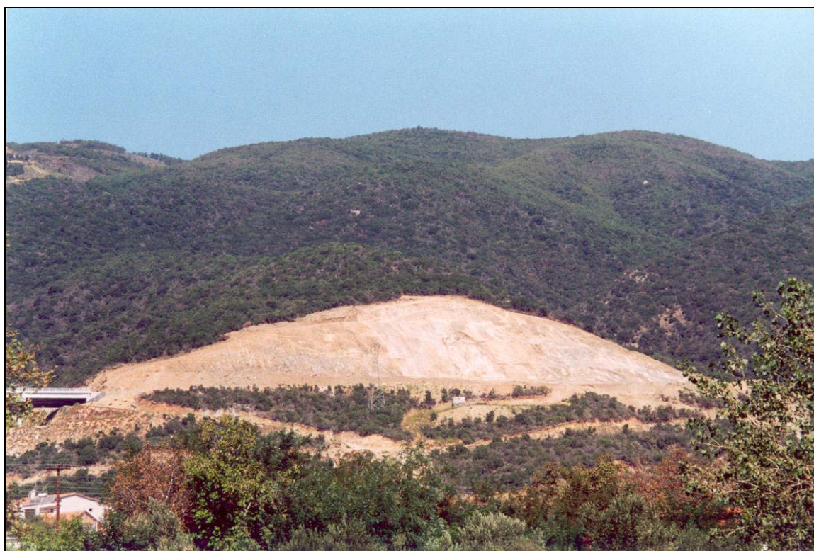
Εικόνα 7.1. Κατολίσθηση αναβαθμίδων το Μάρτιο του 2002
