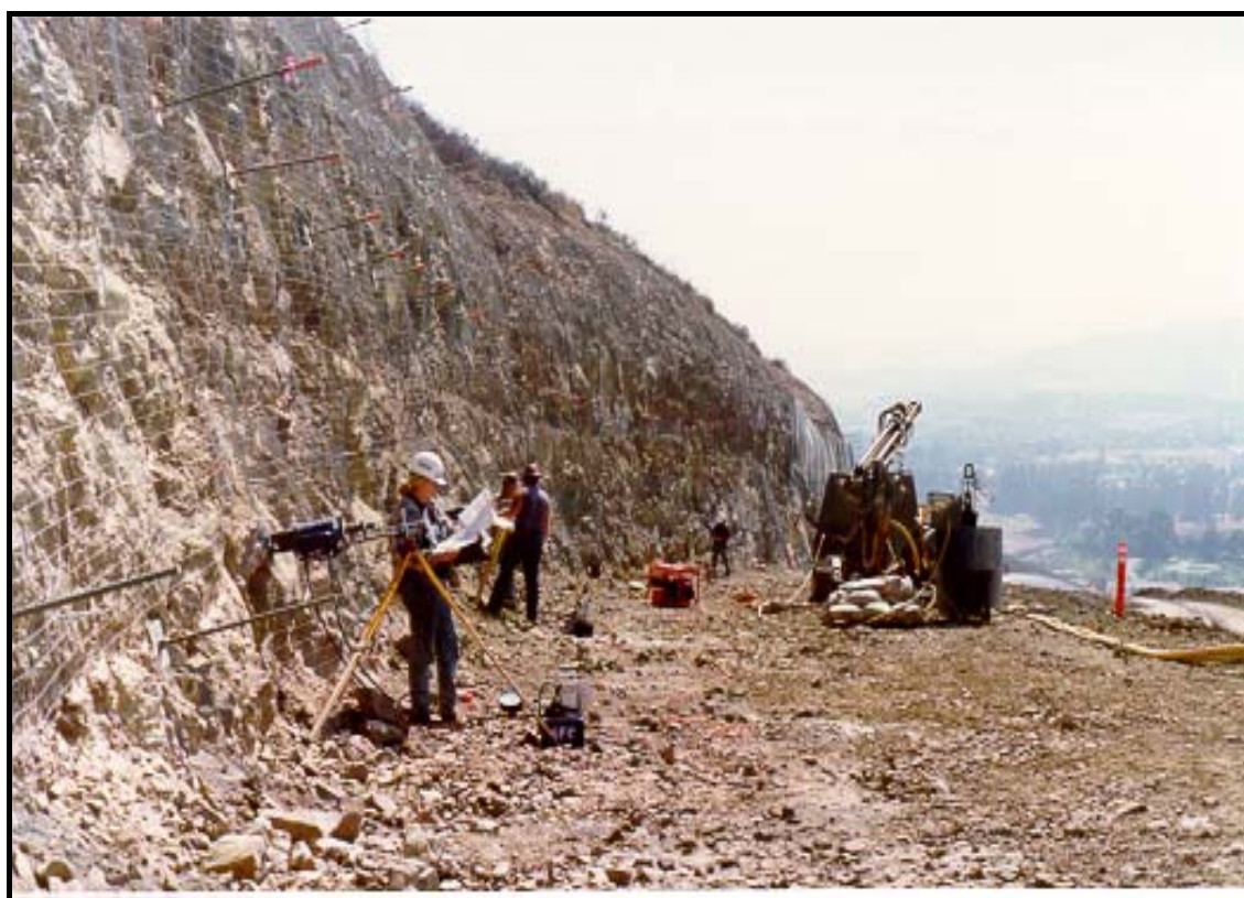
Σχήμα 6.28. Συνδυασμός συρμάτινων πλεγμάτων και συστήματος αγκυρώσεων.
