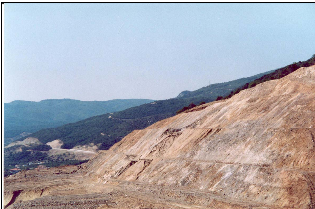
Εικόνα 7.3. Κατολίσθηση αναβαθμίδων το Μάρτιο του 2002
