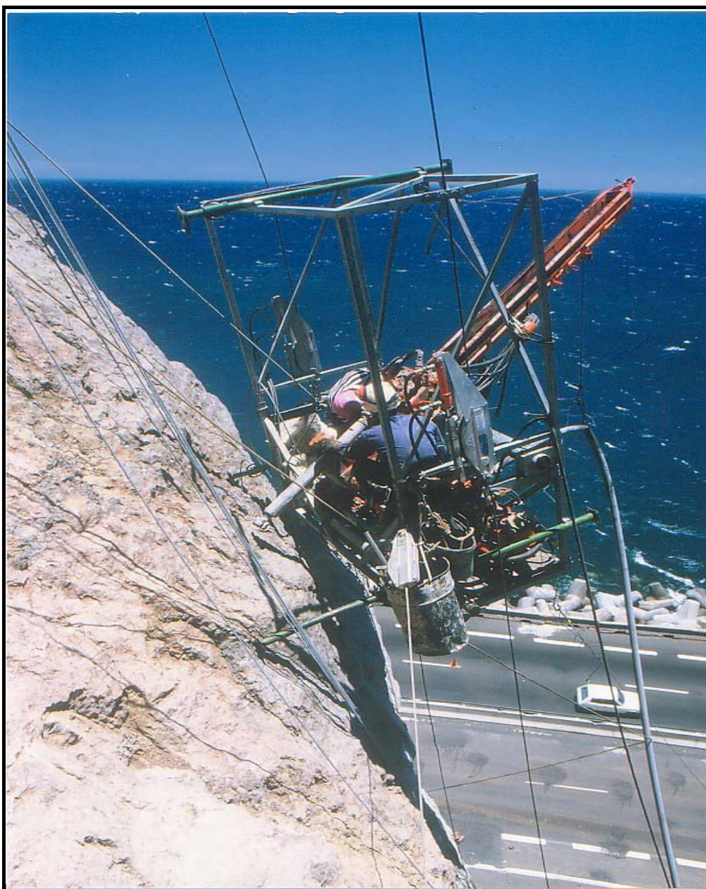
Σχήμα 6.32. Διαδικασία αγκύρωσης απότομου πρανούς.
