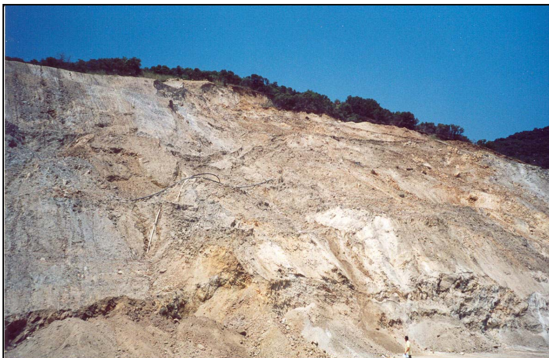
Εικόνα 7.5. Ολική κατάρρευση των αναβαθμίδων. Σημερινή κατάσταση (Σεπτέμβριος 2003)
