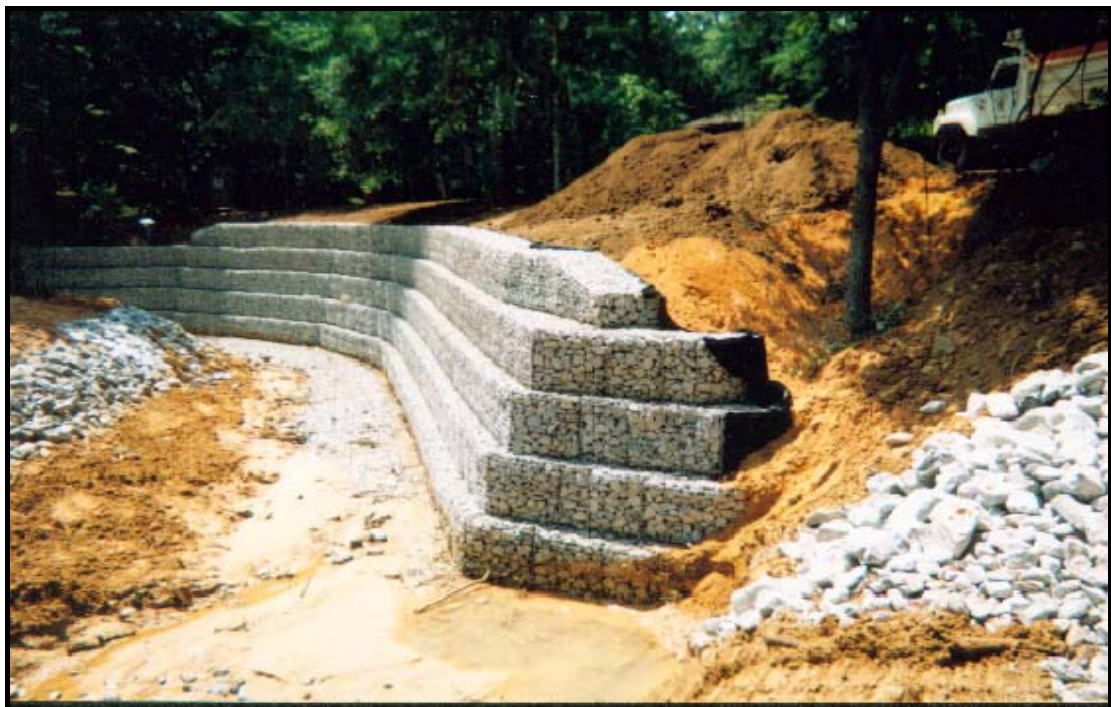
Σχήμα 6.18. Τοίχος αντιστήριξης από σαρζανέτια.
