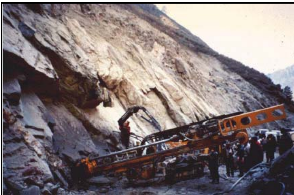
Σχήμα 6.41. Μηχάνημα εγκατάστασης αγκυρίων καλωδίου μήκους 40 m.
