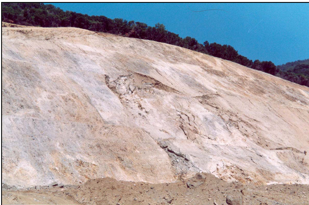
Εικόνα 7.2. Κατολίσθηση αναβαθμίδων το Μάρτιο του 2002
