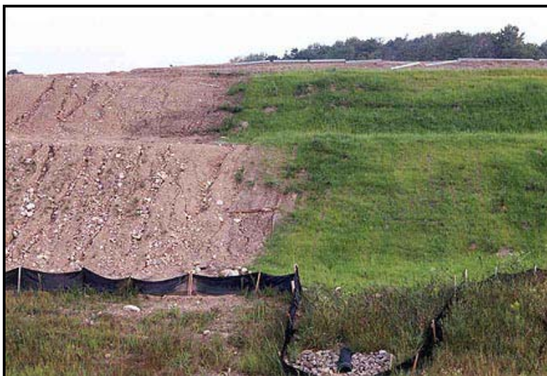
Σχήμα 8.8. Φυτοκάλυψη και σύστημα αποστράγγισης πρανούς
