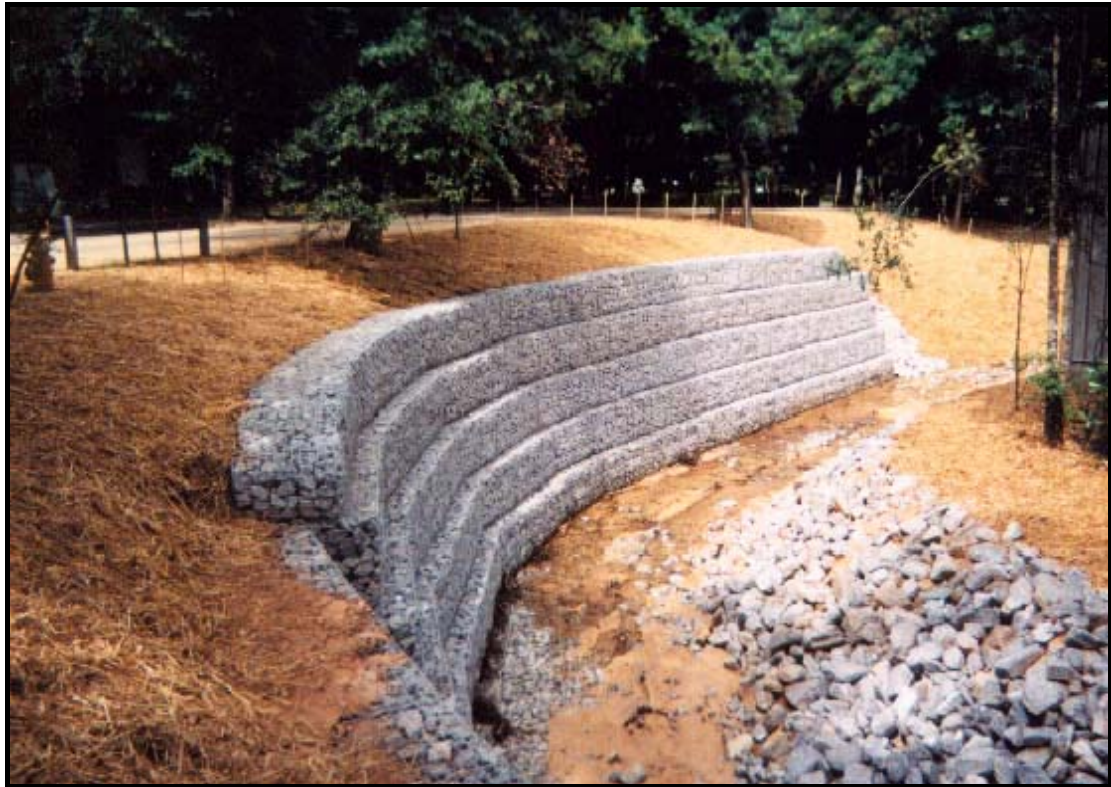
Σχήμα 6.17. Τοίχος αντιστήριξης από σαρζανέτια.
