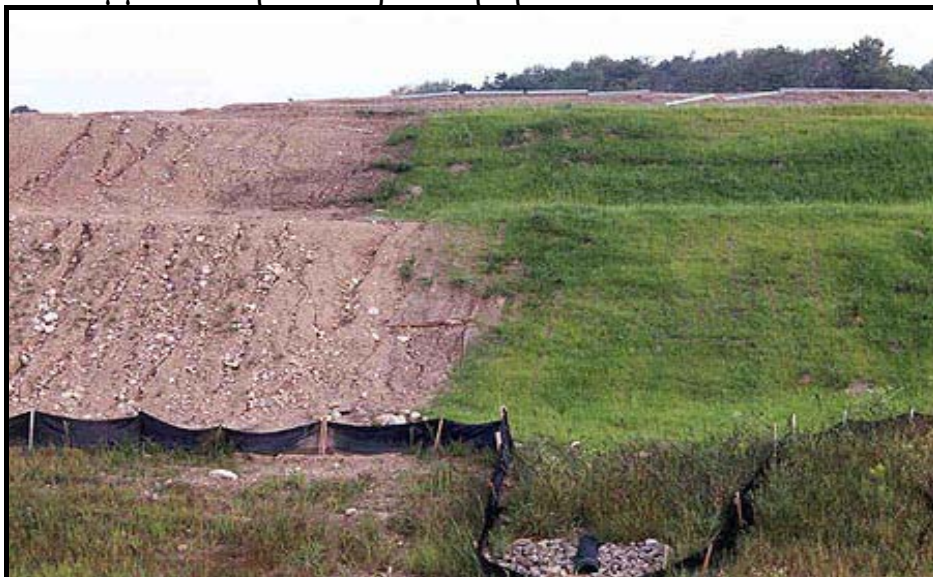
Σχήμα 6.48. Σταθεροποίηση πρανούς με φύτευση χλοοτάπητα (grass mat).
