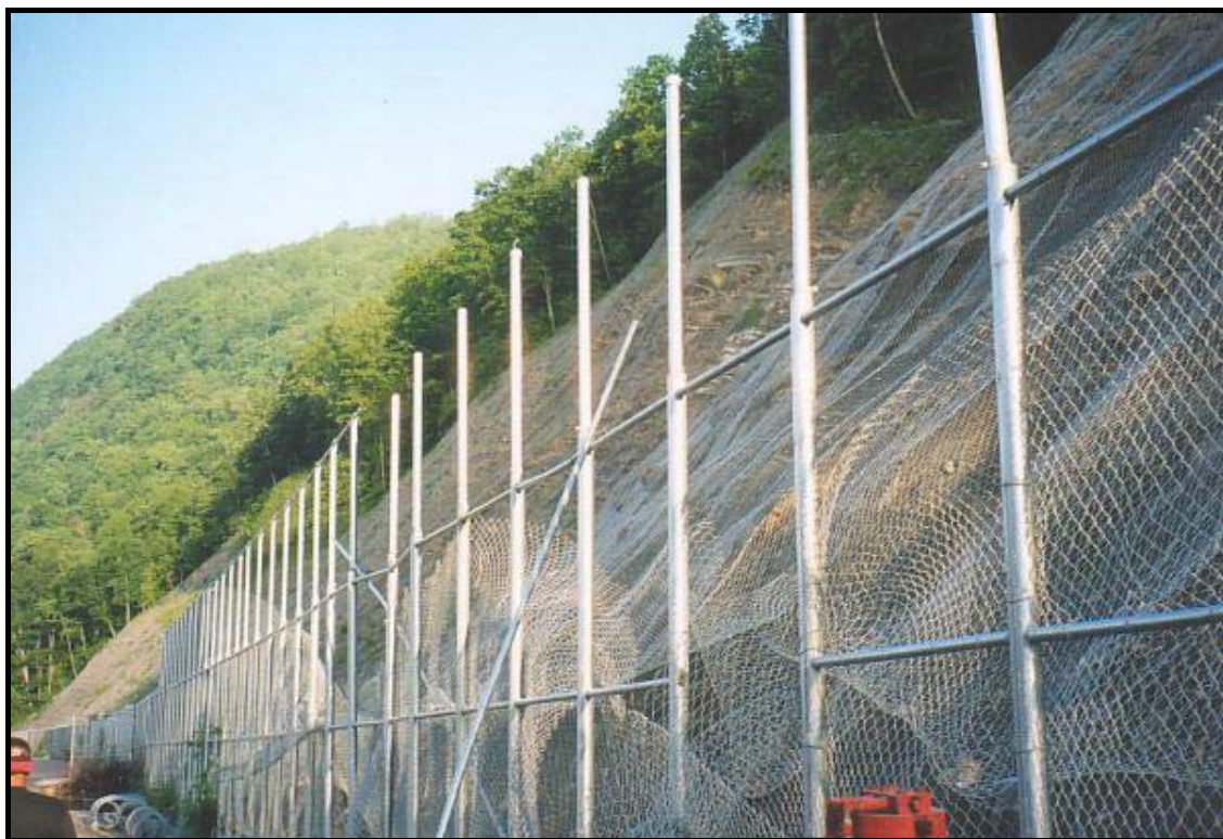
Σχήμα 6.29. Προστασία δρόμου από καταπτώσεις βραχωδών τεμαχίων με χρήση συρμάτων πλεγμάτων.
