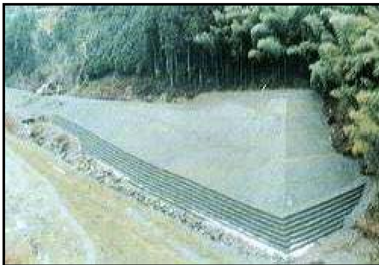
Σχήμα 6.15. Rock – filled buttress (Hunt, 1984).
