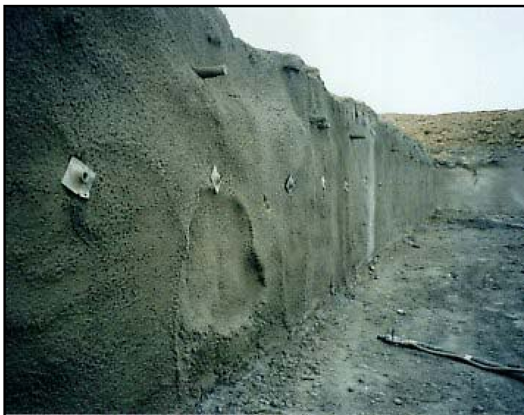
Σχήμα 6.34. Σύστημα αντιστήριξης με αγκύρια, πλέγμα και εκτοξευόμενο σκυρόδεμα (τελικό στάδιο).
