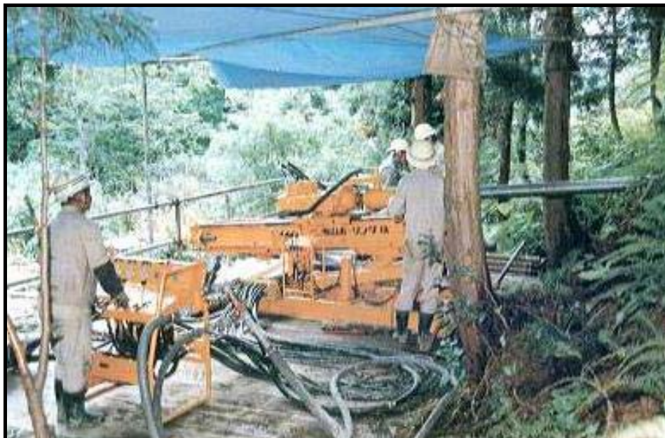
Σχήμα 6.7. Εργασίες κατασκευής οριζόντιων αποστραγγιστικών γεωτρήσεων.
