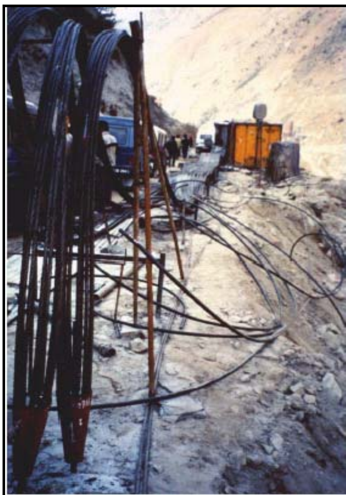
Σχήμα 6.42. Προετοιμασία εγκατάστασης αγκυρίων καλωδίου μήκους 40 m και ικανότητας 200 tons το καθένα, σε εκσκαφή φράγματος.
