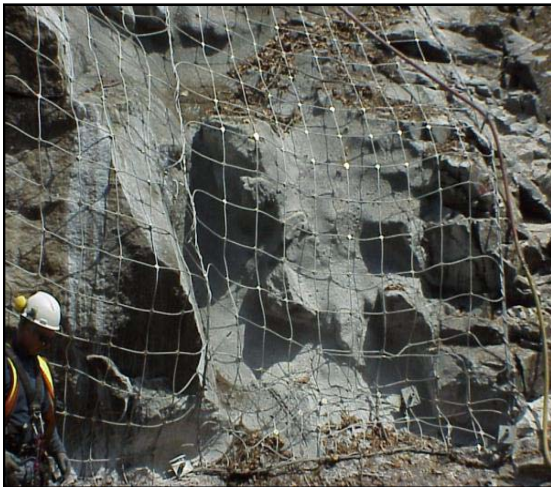
Σχήμα 6.31. Προστασία πρανούς με εκτοξευόμενο σκυρόδεμα σε συνδυασμό με τοποθέτηση συρμάτων πλεγμάτων συγκράτησης.
