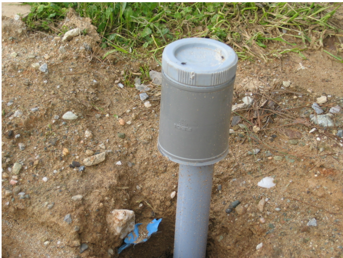
Εικόνα 19. Τοποθέτηση πιεζομέτρου μετά το τέλος της γεώτρησης
