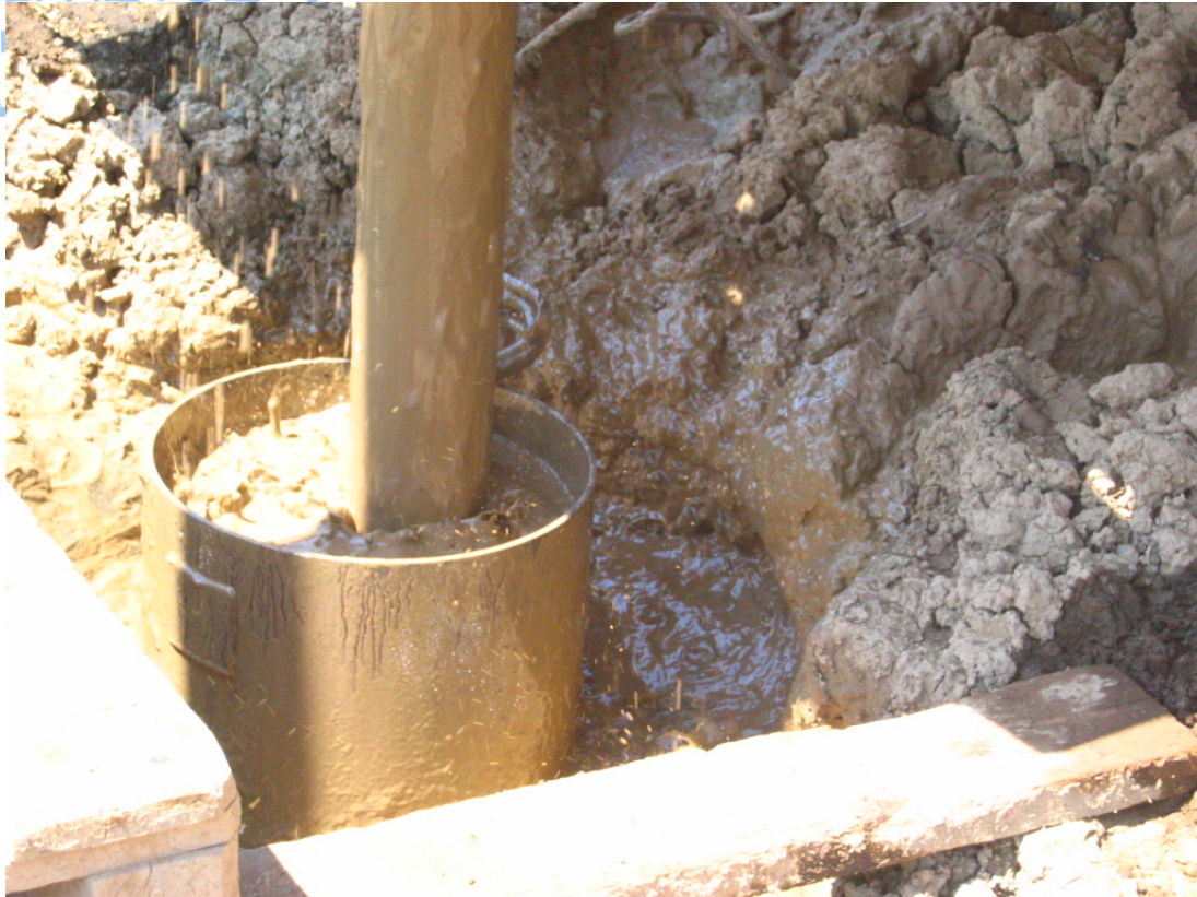
Εικόνα 8. Τοποθέτηση περιφραγματικού σωλήνα
