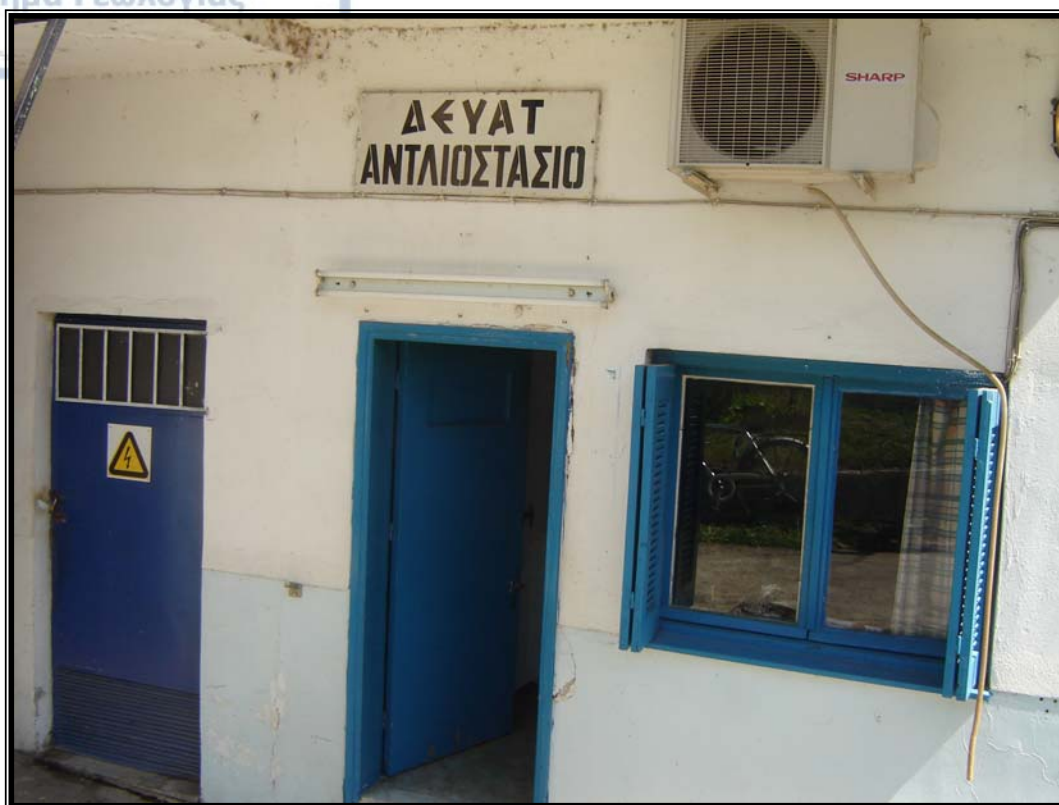
(Κεντρικό αντλιοστάσιο Ν. Τρικάλων)
