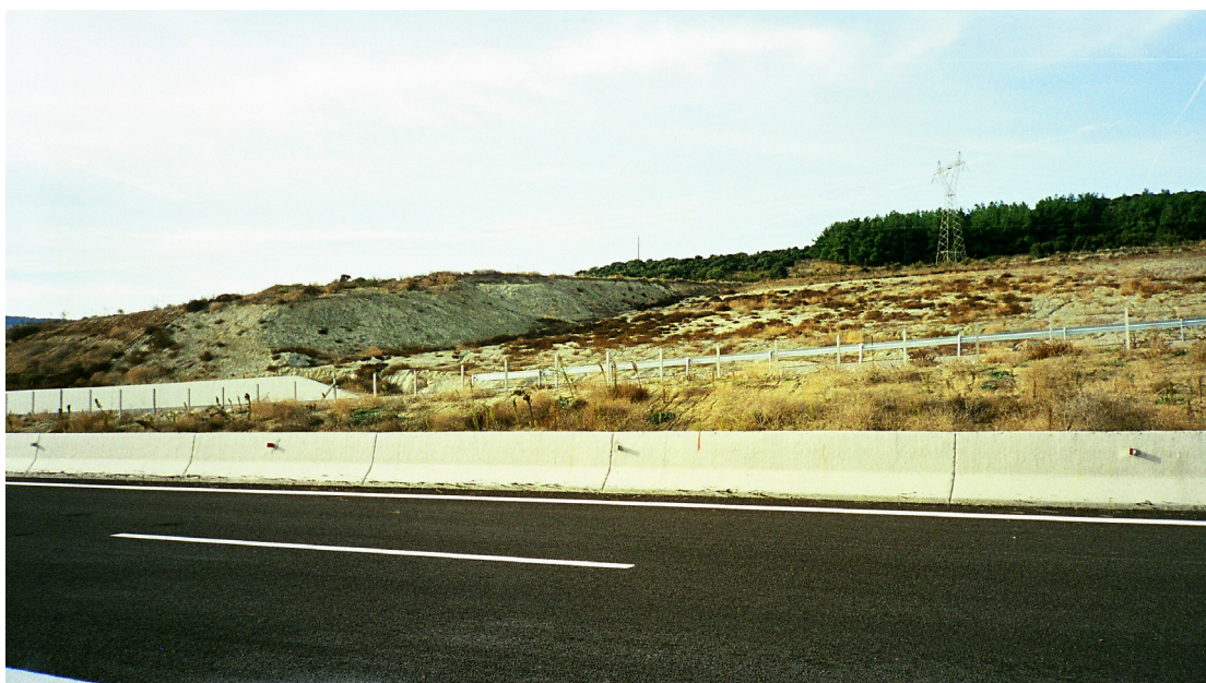
Φωτ. 9 : Κατολίσθηση στη θέση 10 της περιοχής Ασπροβάλτα – Στρυμόνα. Η επιφάνεια ολίσθησης έχει ισοπεδωθεί προκειμένου να αντιμετωπιστεί το φαινόμενο των κατολισθήσεων.
