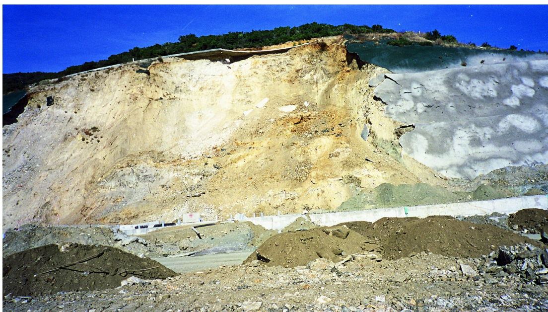
Φωτ. 5 : Ροή κορημάτων στη θέση 4 της περιοχής Ασπροβάλτα – Στρυμόνα. Παρόλο που η επιφάνεια ολίσθησης καλύφθηκε με στρώμα τσιμέντου, το πρανές έχει καταρρεύσει.
