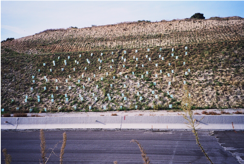
Φωτ. 7 : Ολίσθηση κορημάτων στη θέση 6 της περιοχής Ασπροβάλτα – Στρυμόνα. Στην επιφάνεια ολίσθησης κατασκευάστηκαν αναβαθμίδες με σκοπό να αποφευχθούν μελλοντικές κατολισθήσεις. Επιπλέον, στη βάση της κατολίσθησης έχει κατασκευαστεί τοιχίο αντιστήριξης.
