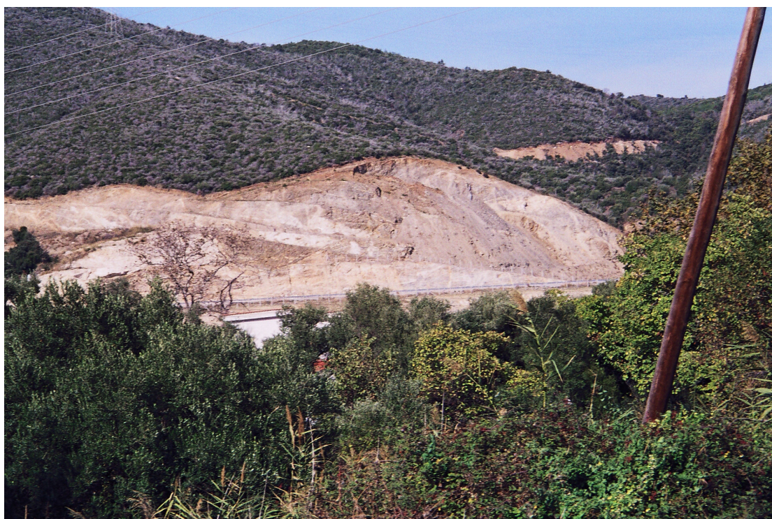
Φωτ. 6 : Περιστροφική ολίσθηση στη θέση 5 της περιοχής Ασπροβάλτα – Στρυμόνα.
