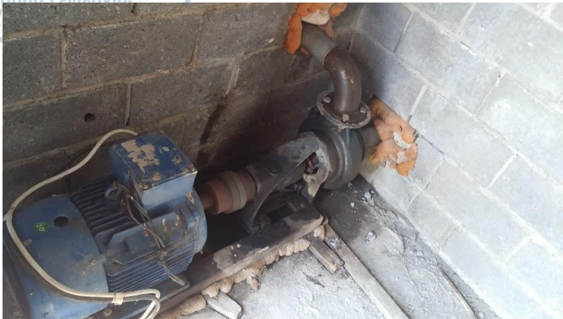
Εικόνα 11: Γεώτρηση από την περιοχή μελέτης.
