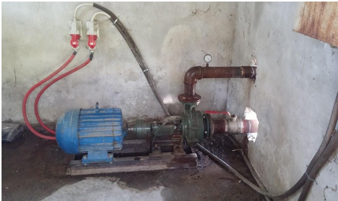
Εικόνα 9. Γεώτρηση από την περιοχή μελέτης.
