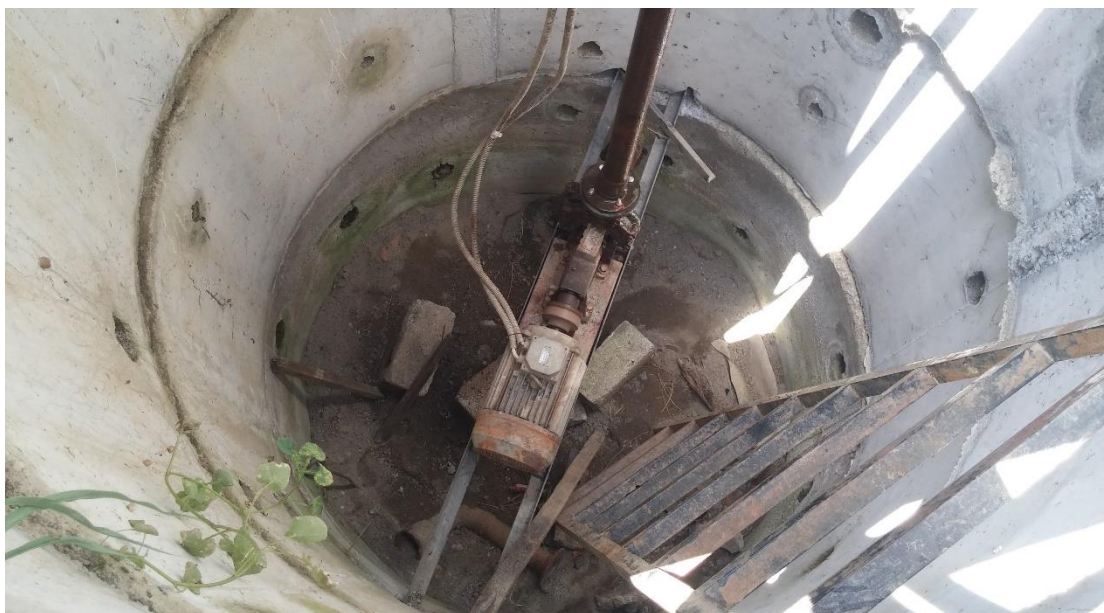
Εικόνα 10: Γεώτρηση από την περιοχή μελέτης.
