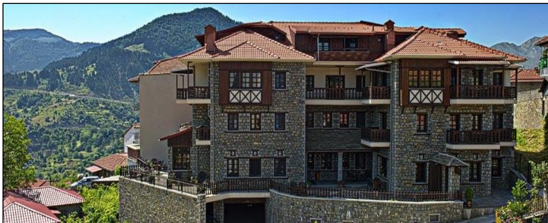
Εικόνα 24. Ξενοδοχείο στο Μέτσοβο (Ν. Ιωαννίνων) στο οποία εγκαταστάθηκε σύστημα ΓΑΘ
