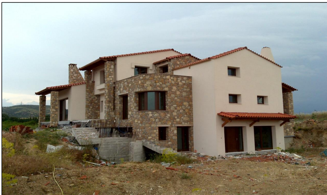
Εικόνα 5. Μονοκατοικία στην περιοχή Μελισσοχωρίου (Ωραιόκαστρο Θεσσαλονίκης) στην οποία εγκαταστάθηκε σύστημα ΓΑΘ
