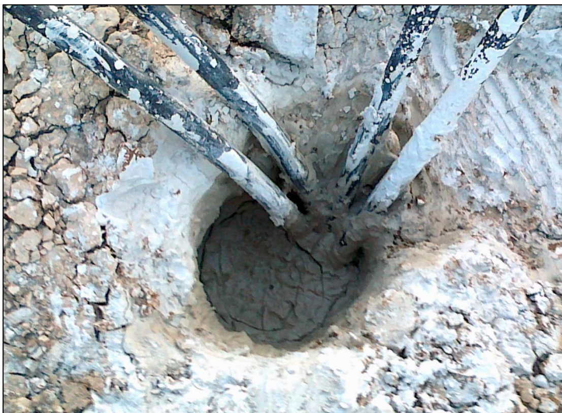
Εικόνα 21. Η οπή της γεώτρησης μετά την πλήρωσή της με το θερμοδιαπερατό υλικό.
