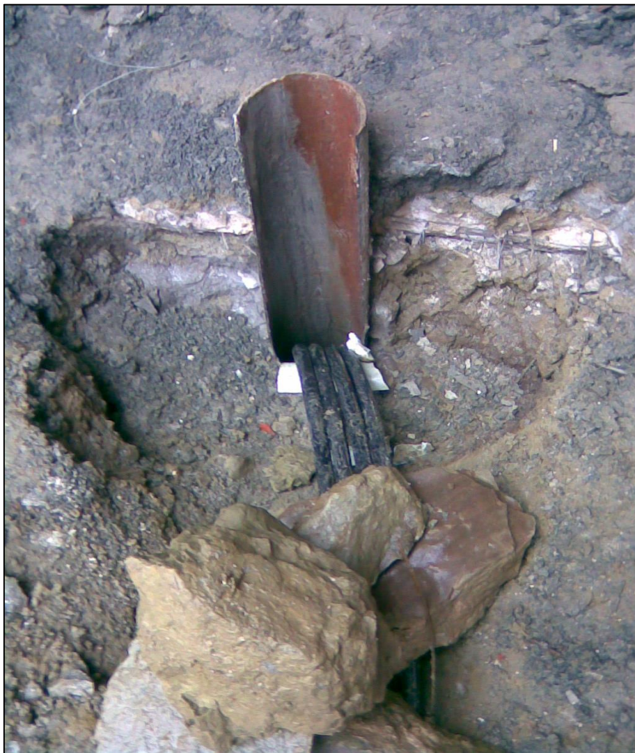
Εικόνα 26. Γεώτρηση μετά την πλήρωση της με το θερμοδιαπερατό υλικό, όπου διακρίνεται και ο περιφραγματικός σωλήνας
