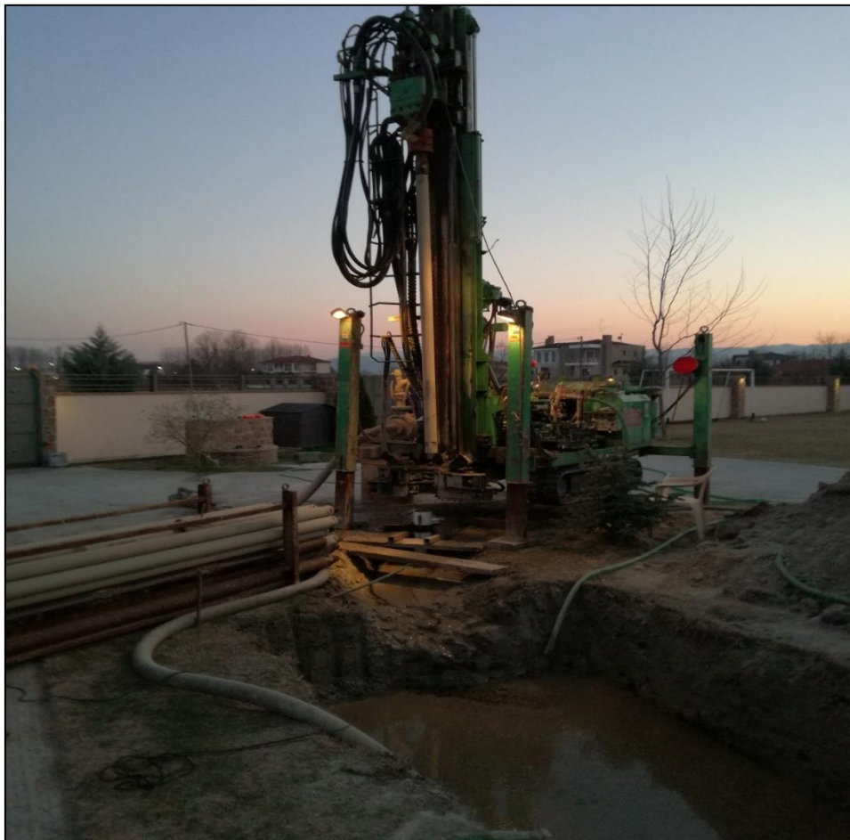
Εικόνα 7. Εργασίες κατασκευής των γεωτρήσεων στην περιοχή Μελισσοχωρίου
