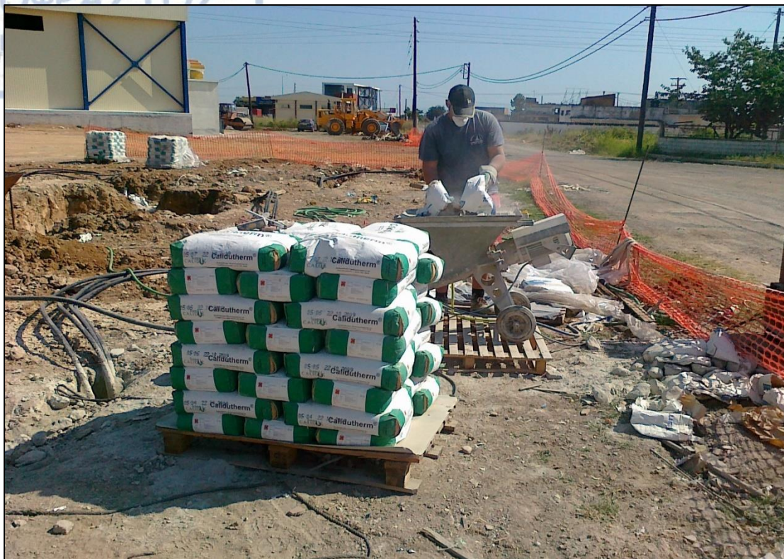
Εικόνα 20. Πλήρωση της γεώτρησης με το υλικό CALIDUTHERM μετά από την τοποθέτηση του γεωεναλλάκτη.
