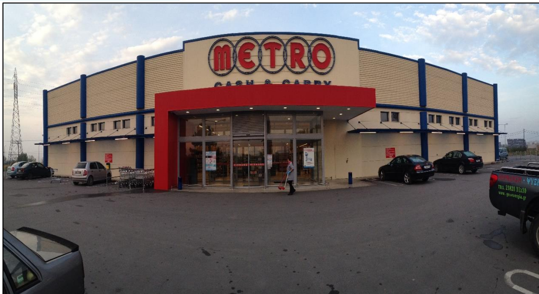
Εικόνα 10. Κατάστημα Super Market METRO στην περιοχή Γιαννιτσών (Δ. Πέλλας) στην οποία εγκαταστάθηκε σύστημα ΓΑΘ
