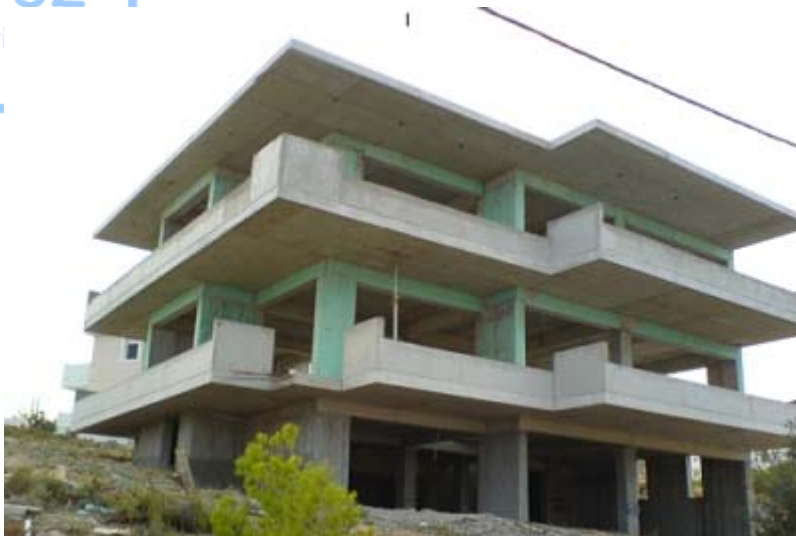
Φωτ. 12. Οικοδόμηση κτιρίων.
