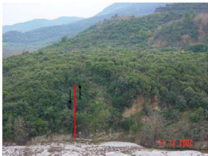
Φωτ. 7: Κανονικό ρήγμα στο πρηνές της κοίτης του Ευήνου ποταμού σε απόσταση 100m από το ακρόβαθρο 1 το οποίο βυθίζει (στα αριστερά) τα κροκαλοπαγή (ft.c). Δεξιά του ρήγματος διακρίνεται η ψαμμιτική φάση του φλύσχη (ft.st).
