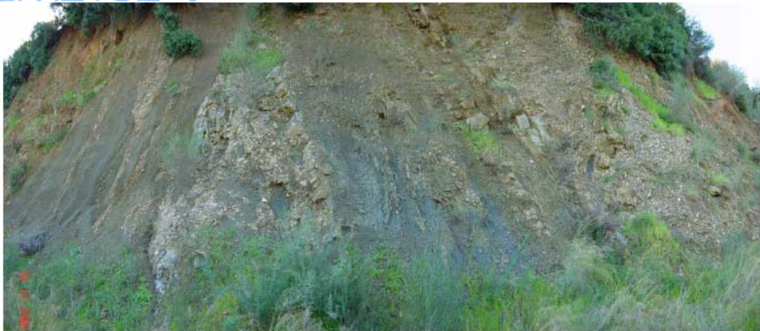
Φωτ. 5: Κροκαλοπαγή, αργιλοί σχίστες και ψαμμίτες (ft.c) πολυπτυχωμένα, στο πρηνές της κοίτης του Ευήνου ποταμού.
