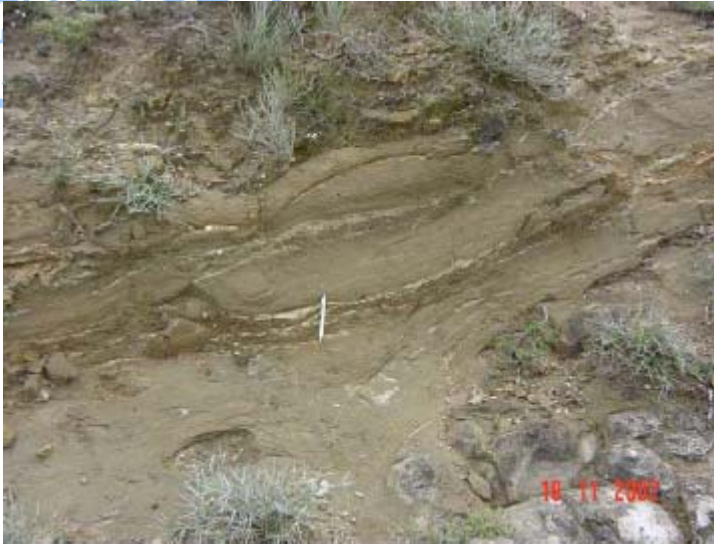
Φωτ. 11: Ιζηματοδομές στην ψαμμιτική φάση του φλύσχη της Ιόνιας γεωτεκτονικής ενότητας (fi.st) λόγω αποσάθρωσης.
